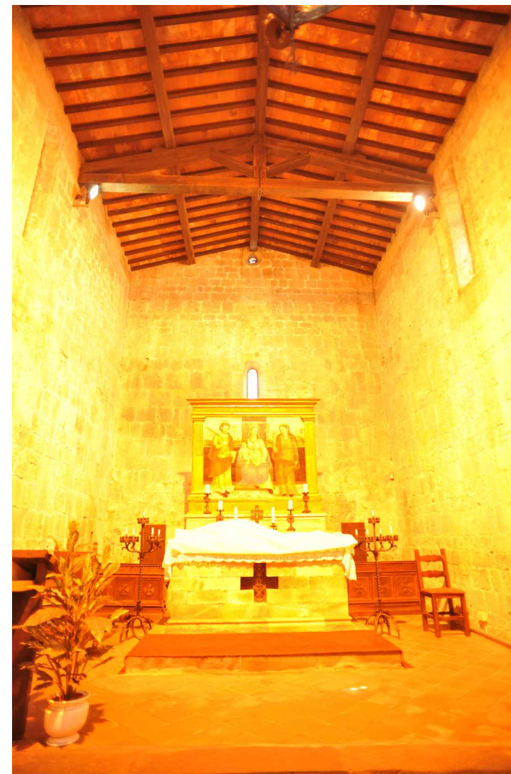
COPERTURA DI LEGNO E MATTONI
