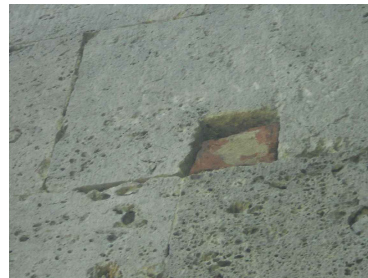
CAVO CON ELEMENTO IN CERAMICA
