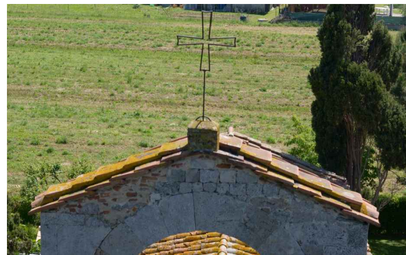
CROCE METALLICA. RIPIENO DI CEMENTO E MATTONE
