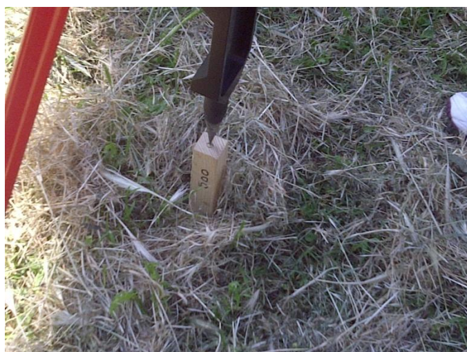
Collocazione target alla stazione 500
