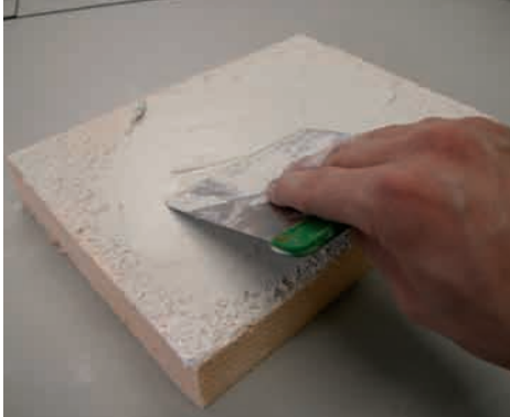
Fig.4.45 Aplicación del enlucido.
