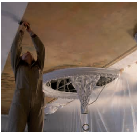
Fig.I.5 Adesione dello sfondo stampato al tetto.
