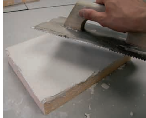
Fig.4.46 Alisado con llana semirígida.
