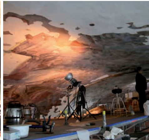
Fig.I.14 Aspecto de la bóveda reconstruida.
