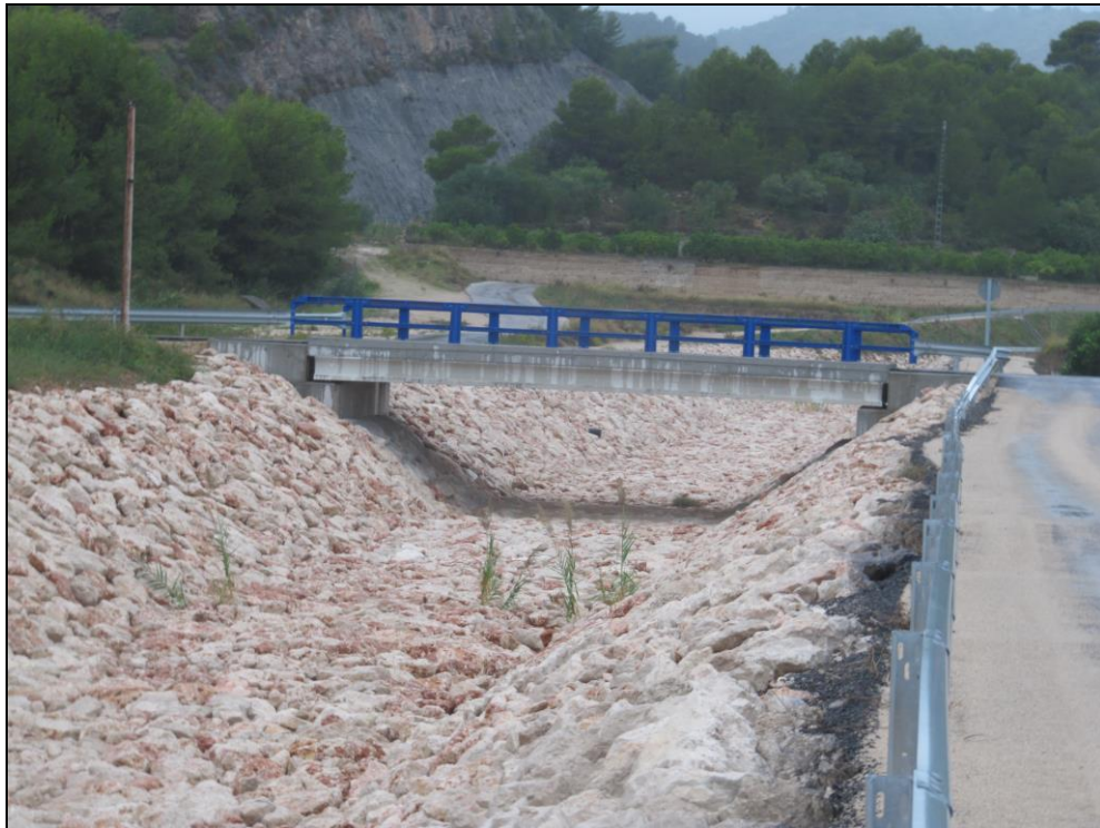
Encauzamiento artificial Rambla Gallinera en la parte baja de la cuenca
