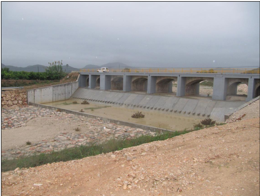
Estructura hidráulica II de laminación en el encauzamiento final de la Rambla Gallinera
