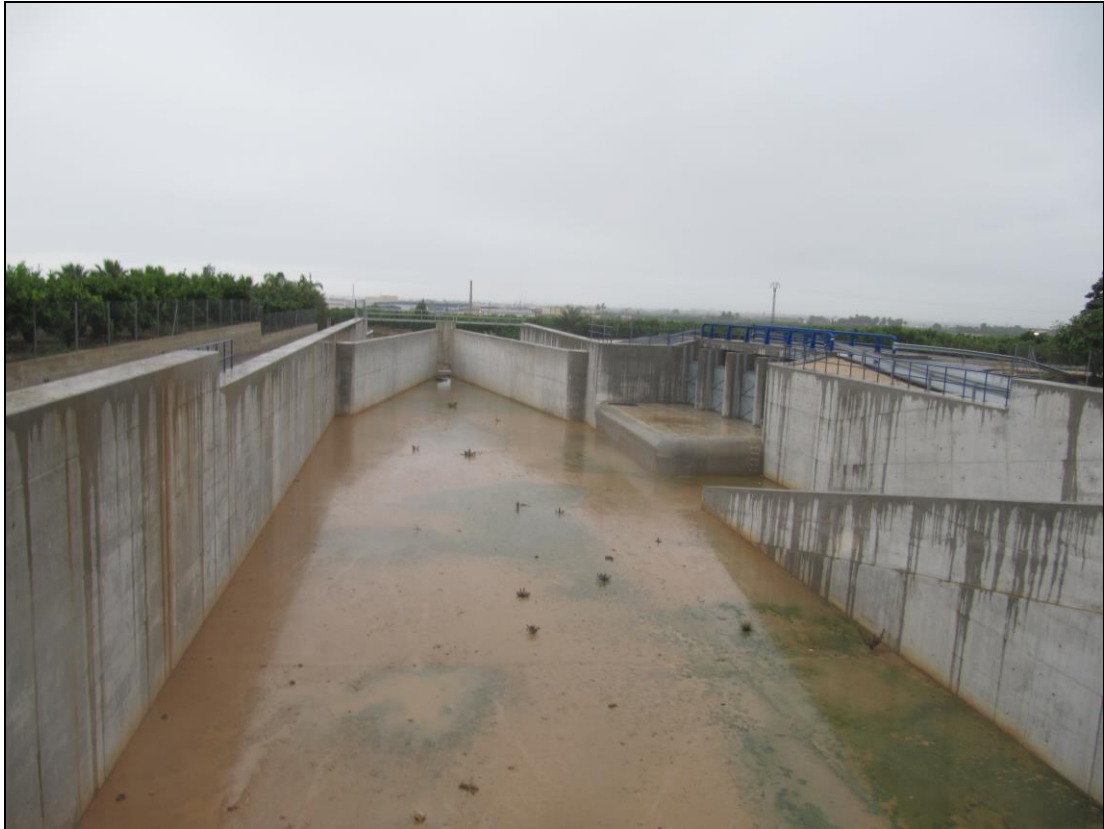
Estructura hidráulica I de laminación en el encauzamiento final de la Rambla Gallinera
