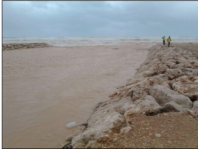
Figura 1. Encauzamiento al mar de la Rambla Gallinera en un episodio de crecida.
