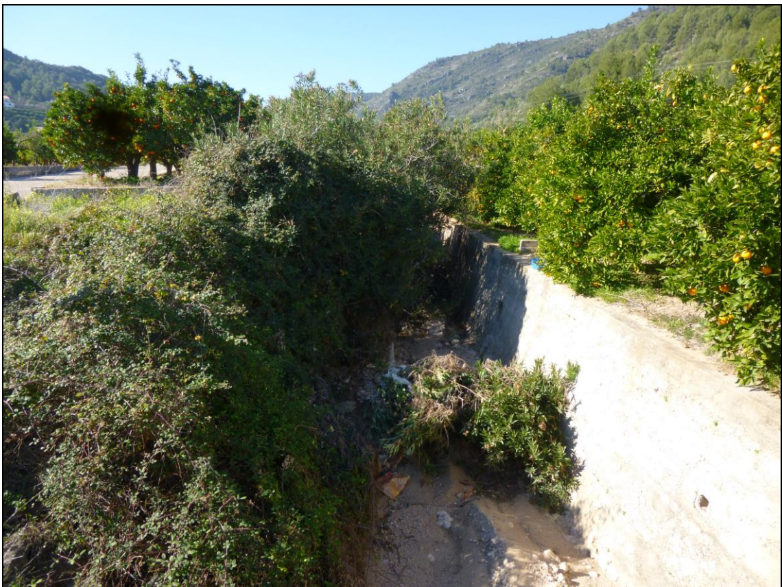
Cauce Gallinera en parte media
