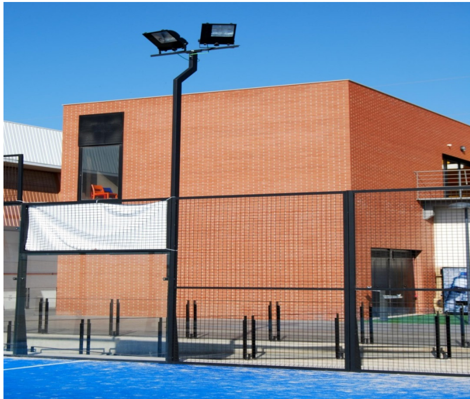
Ilustración 8. Vallas de protección pádel.
