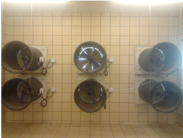
Figura 4: Imagen de la pared Este de la sala con los seis sistemas de extracción (izq.) y componentes de cada turbina de extracción (der.)
