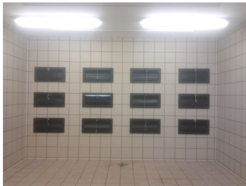
Figura 5: Imagen de la pared Oeste de la sala con las doce ventanas abatibles (izq.) y sistema para la apertura de la ventana (der.)
