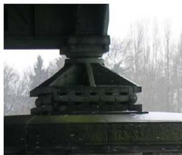
Figura 4. Apoyo simple o articulado-deslizante
