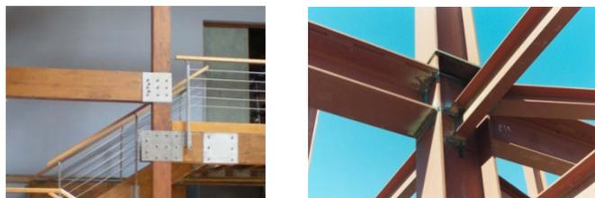
Figura 7. Conexión rígida. Barras empotradas elásticamente a los nudos.
