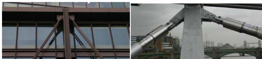
Figura 8. Desconexión total a giro.
