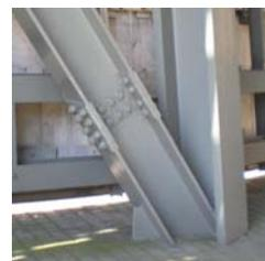
Figura 10. Ejemplo de nudo libre y empotramiento en estructura metálica.
