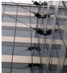
Figura 9. Desconexión elástica.
