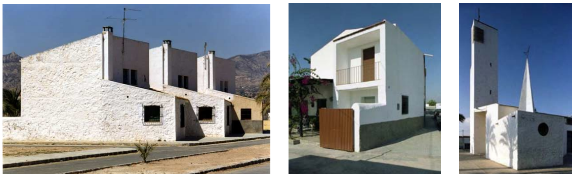
Fig. 2 - 61. CREVILLEN. Poblado del Realengo (1957-1961). Arquitecto: José Luis Fernández del Amo.
