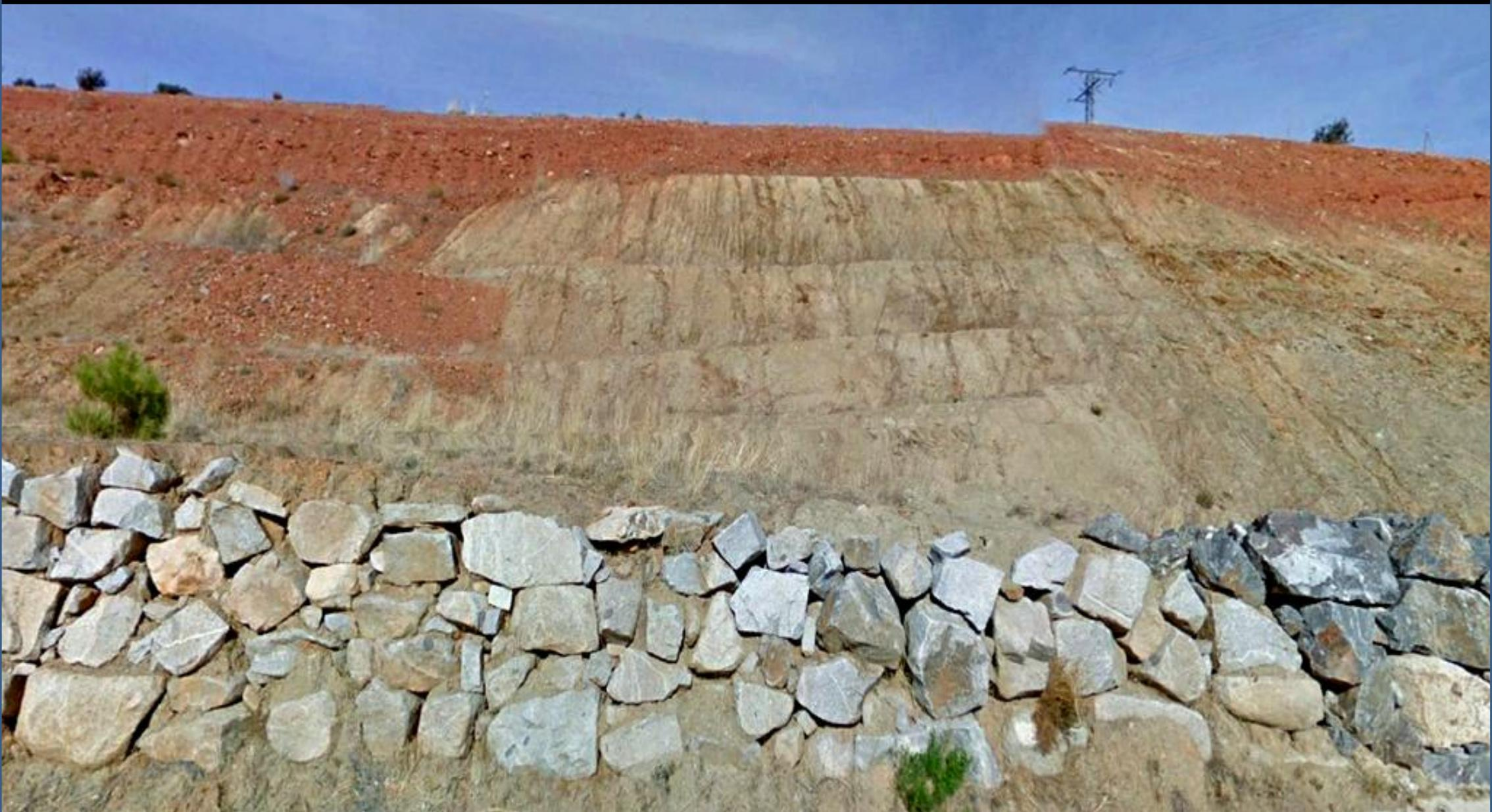
Muro para estabilizar el talud de filitas y pizarras del Precámbrico-Cámbrico. SW de Aldeavieja, Ávila. SW Hoja de El Espinar.
