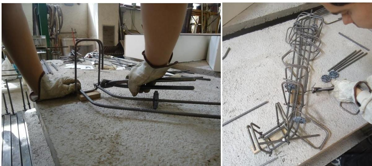
**Figura 8.10.** Proceso de armado.
