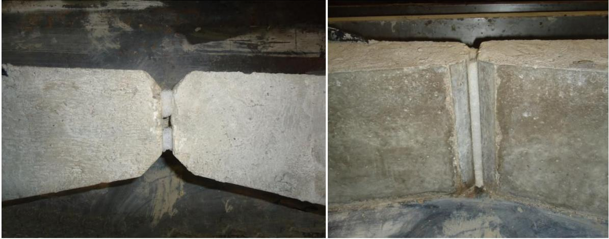
**Figura 8.31.** Colocación de material fácilmente deformable en la rótula.
