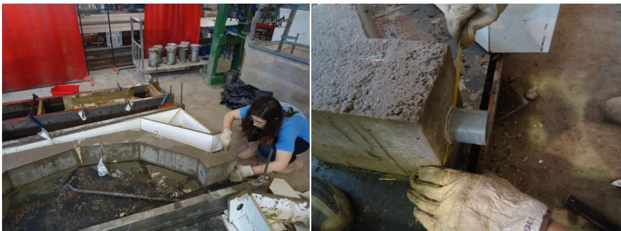
**Figura 8.27.** a) Desencofrado de la estructura; b) Corte del tramo sobrante de los tubos de PVC.
