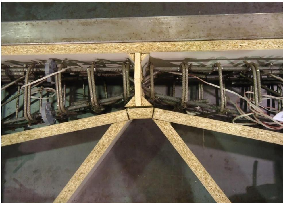
**Figura 8.17.** Montaje inicial para verificar que el encofrado de la rótula encajaba adecuadamente.
