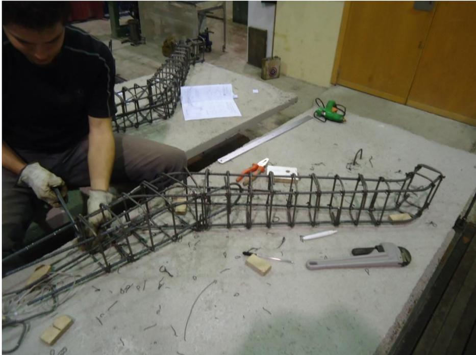
**Figura 8.12.** Armado de la mitad izquierda del arco.
