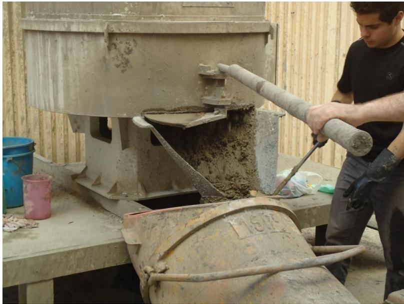
**Figura 8.22.** Vertido del hormigón en la cuba.
