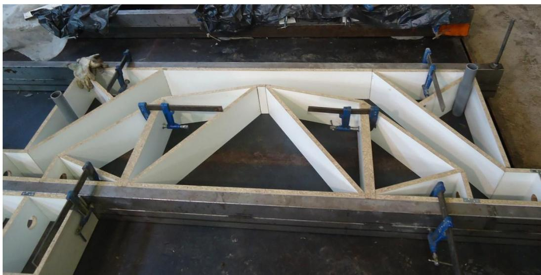
**Figura 8.3.** Encofrado del elemento.
