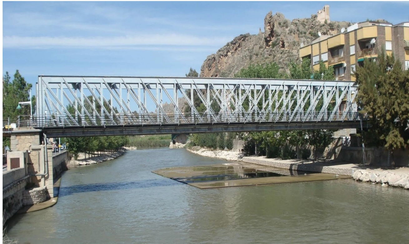
Imagen 3. Puente de Hierro
