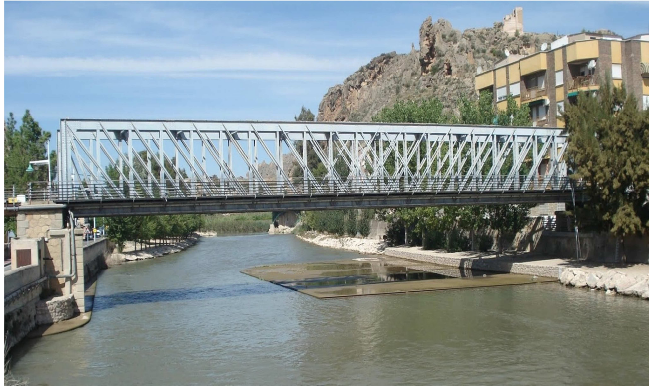
Imagen 3. Puente de Hierro
