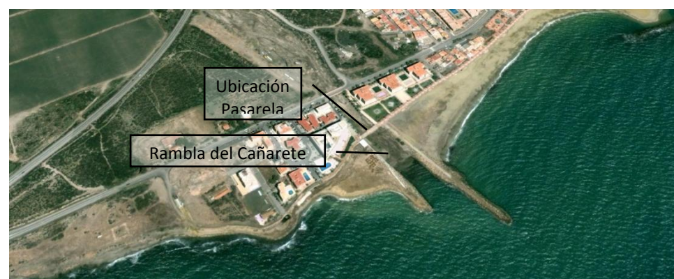
Figura 2.1. Situación de la Pasarela Peatonal. Fuente: Google Earth.
