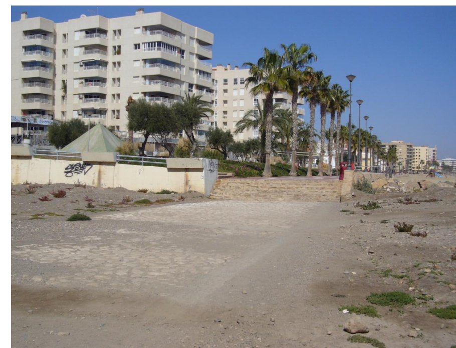
Figura 2.2. Vista actual de la Rambla de Cañarete. Fuente: Propia.
