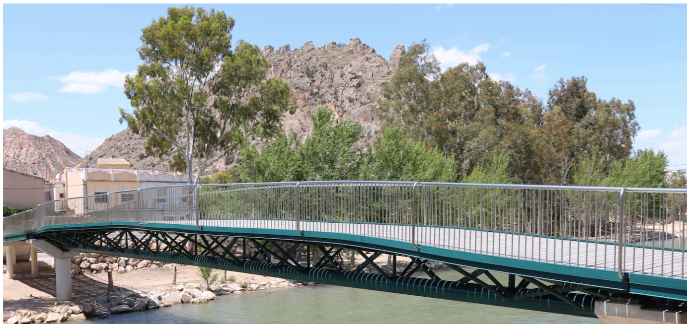
Figura nº. 5 – Pasarela peatonal y ciclista sobre el río Segura en Blanca (construida en el año 2013).
