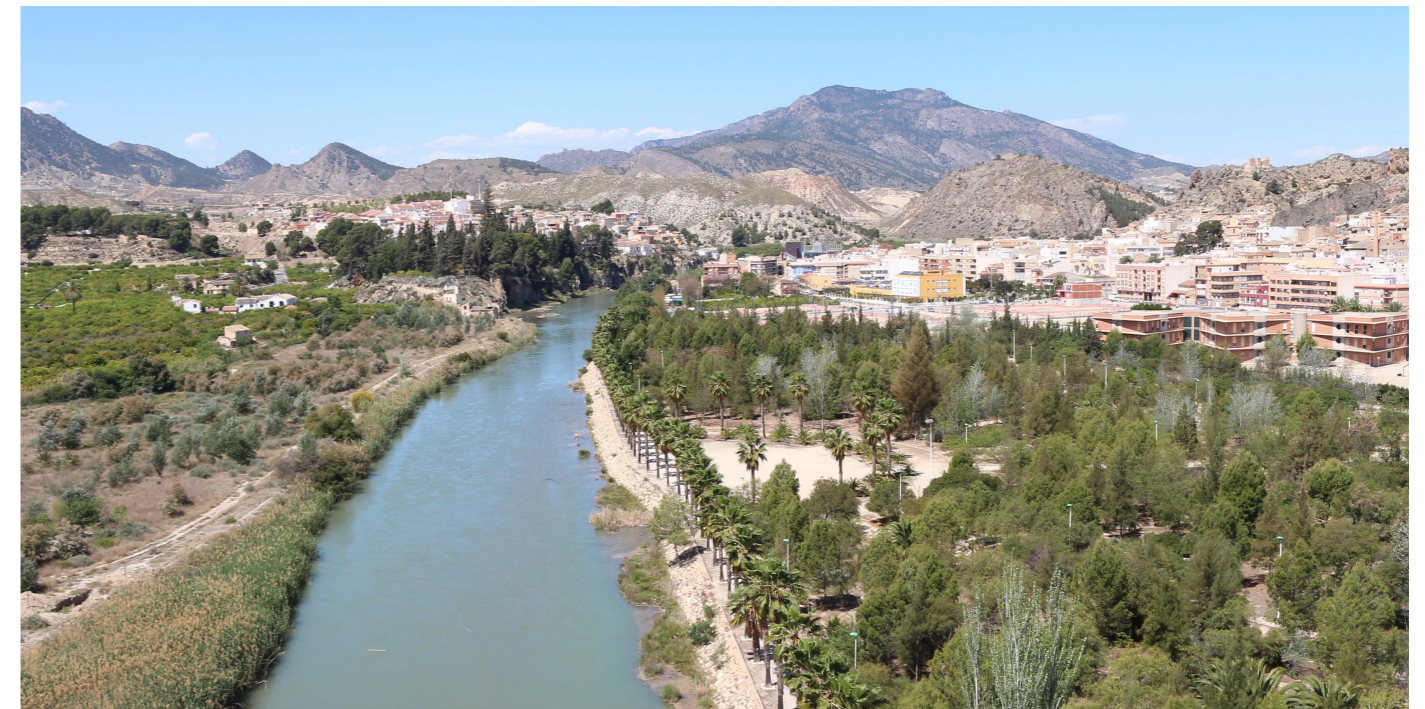
Figura nº. 3 – Vista del río Segura a su paso por Blanca, desde mirador. La pasarela conecta la plaza semicircular con la margen opuesta.
