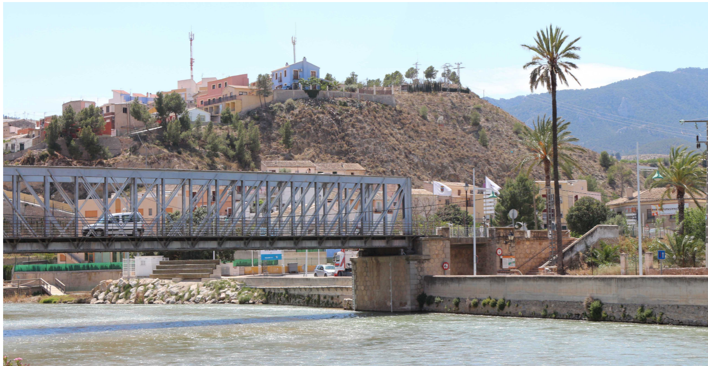
Figura nº. 4 – Puente de Hierro sobre el río Segura en Blanca (construido en el año 1934).
