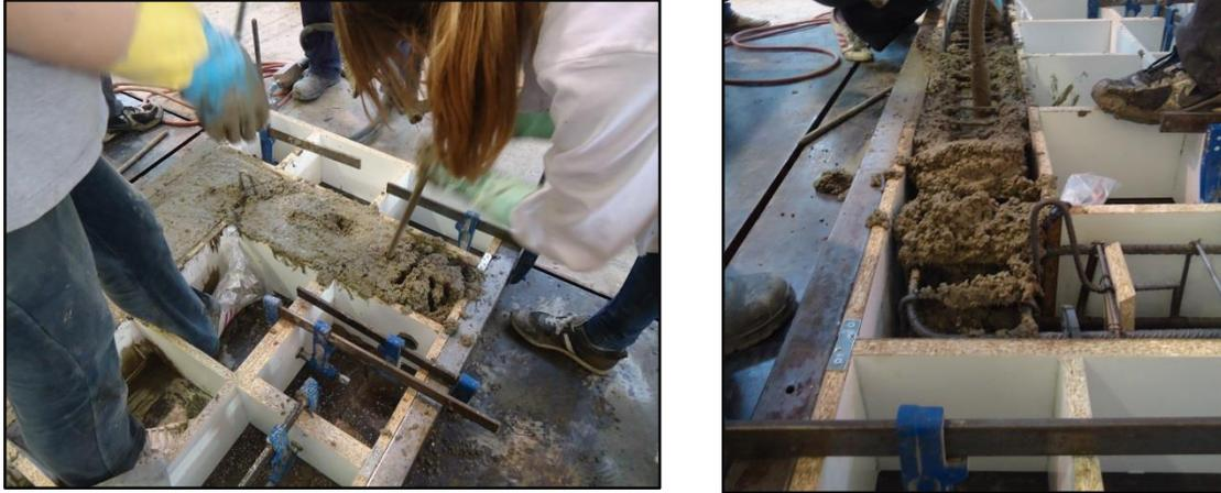
*Fig 3.5.1 Hormigonado de la estructura*
