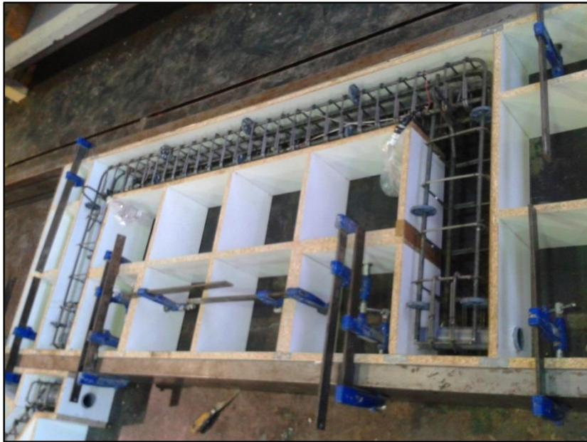
Fig 3.4.1 Montaje del encofrado y armado en la plancha de hormigonado
