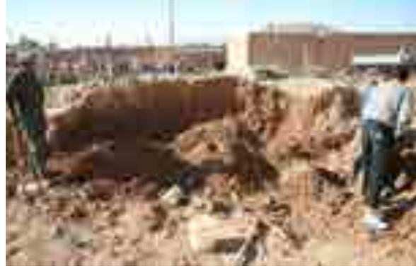
Fig. 5.24. Preparación de la tierra para construir la tapia.
