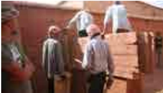
Fig. 5.17. Equipo de trabajo dirigido por el Maâlem construyendo un muro de tapia.
