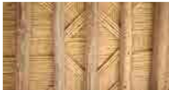
Fig. 5.10. Entrevigado ejecutado con cañas.
