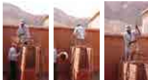
Fig. 5.25. Diferentes fases del proceso de llevado del tapial. Vaciado, distribución y compactación de la tierra con el pisón dentro del cajón.
