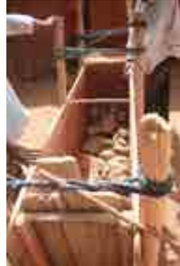
Fig. 5.14. Ejecución de primera hilada de tapia.
