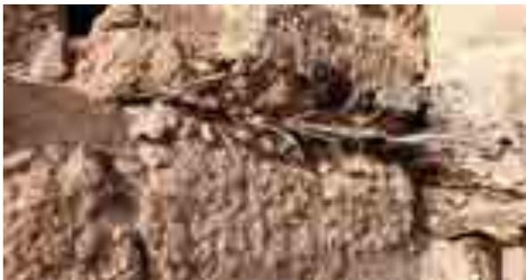
Fig. 5.11. Detalle capa esparto embebida en el forjado.
