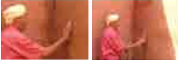
Fig. 5.26. Embarrado y sellado del muro.
