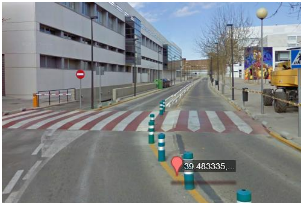
Figura 7.4 Ejemplo de badén ancho en la UPV
