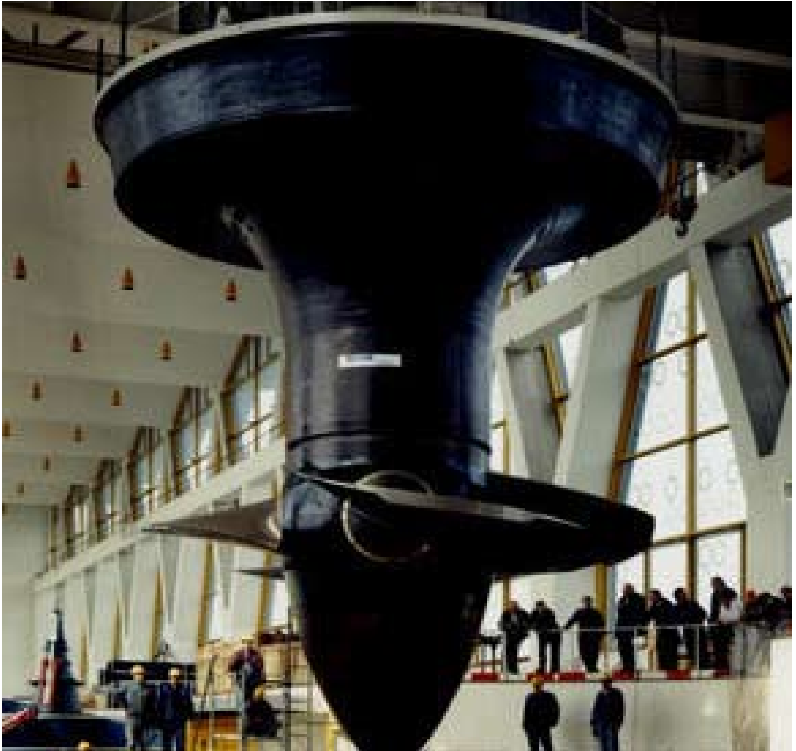
Instalacion de una de las nuevas Turbinas de la Central Hidroeléctrica de Birsfelden, Suiza. 1996
