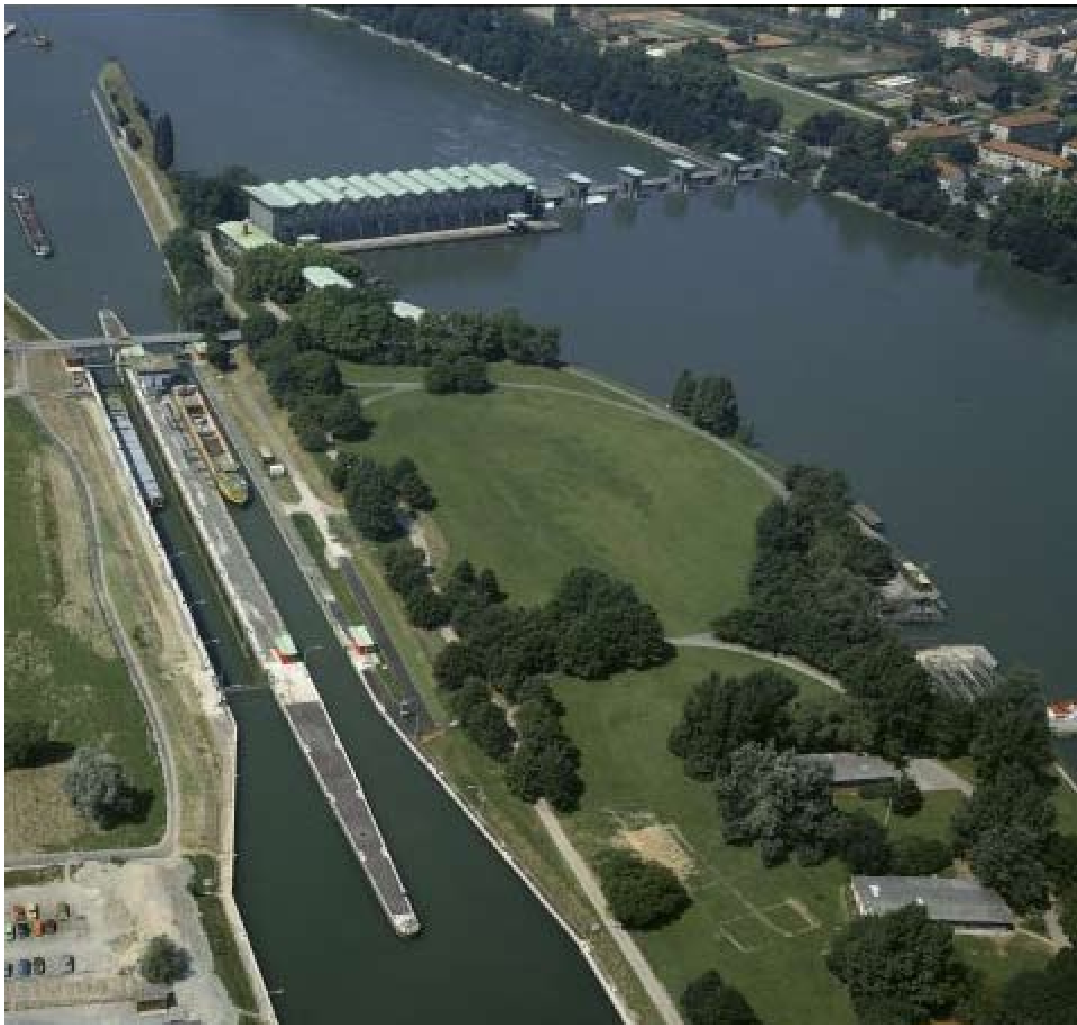
Canal y presa de Birsfelden, junto a la central hidroeléctrica .
