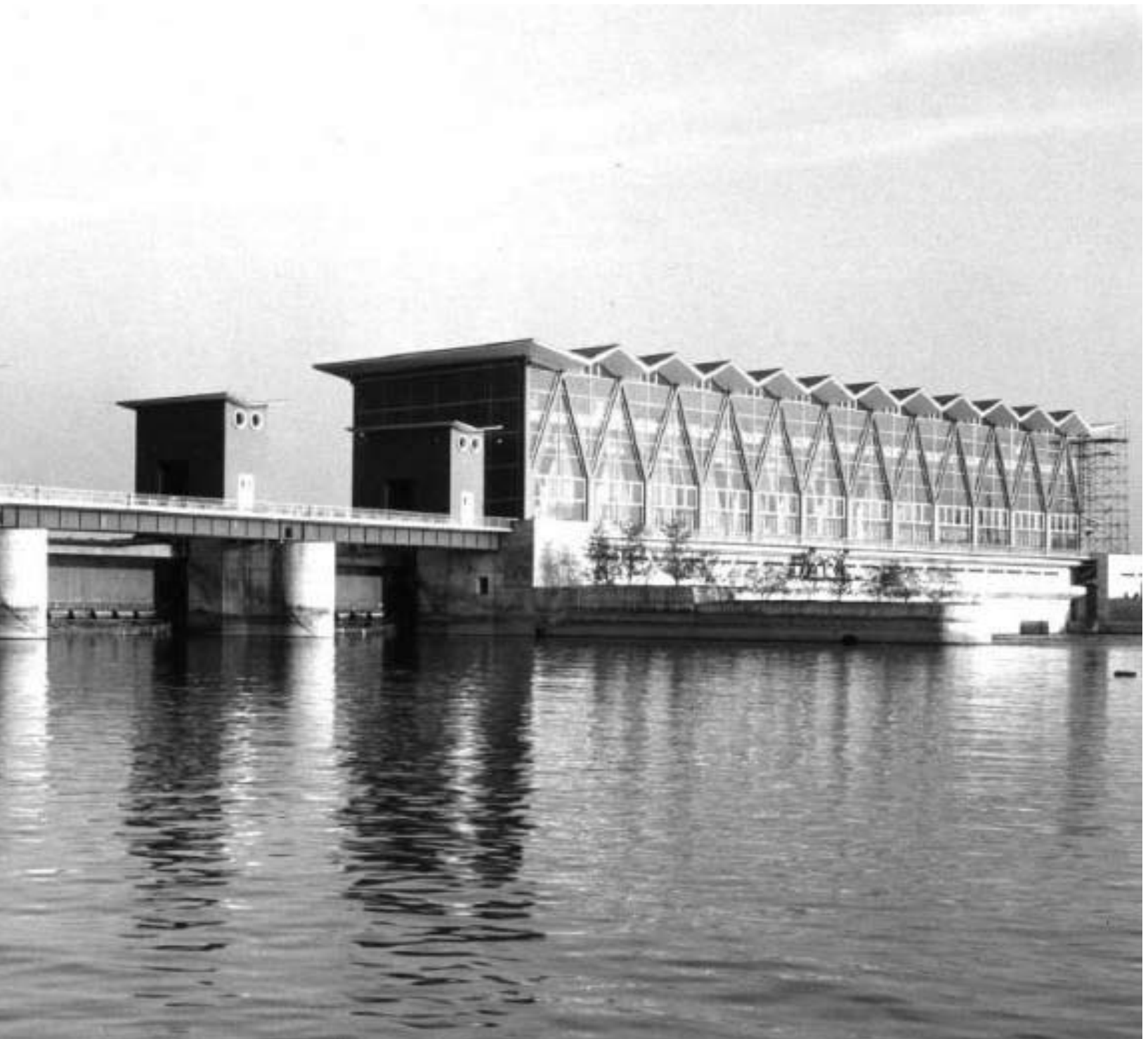
Central Hidroeléctrica y presa de Birsfelden, 1951-55.
