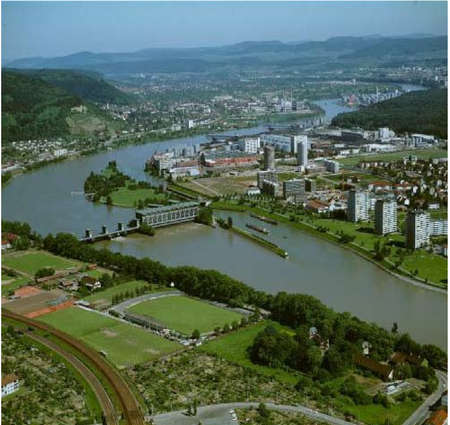
Isla de Birsfelden, con la planta Hidroeléctrica y la presa en primer plano.
