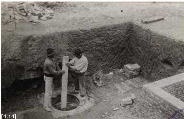
170 Véase 4.8 La Torre del telégrafo. La cimentación de este elemento metálico también se soluciona con el sistema de fundación tubular.
