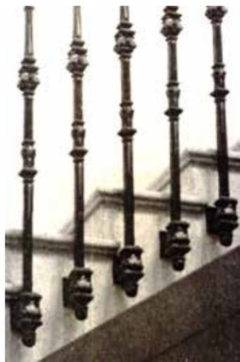
[4.74] De izquierda a derecha. Escalera de Servicio, barrotos de fundición. Escalera de acceso principal, con detalle de los anclajes a la zanca. La foto inferior, escalera de la azotea. Es una combinación de dos barrotos de fundición, en este caso ensamblada en taller y falcada a la obra por los largueros en las pilastras construidas para ello.
