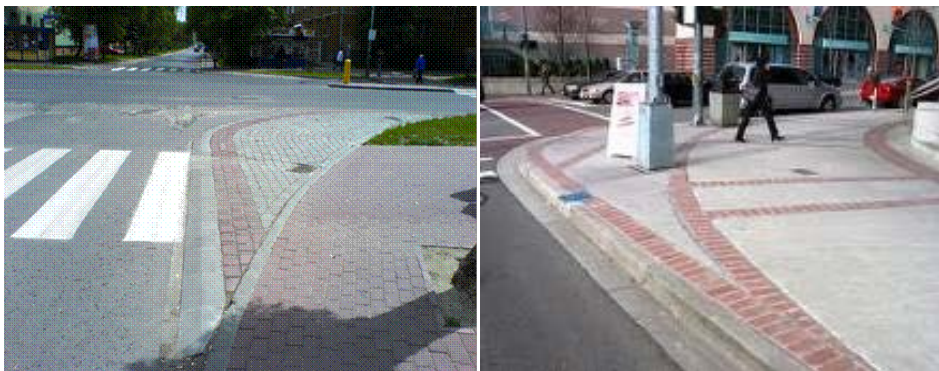
Figura 5. Disminución de radio en giro a la derecha.
