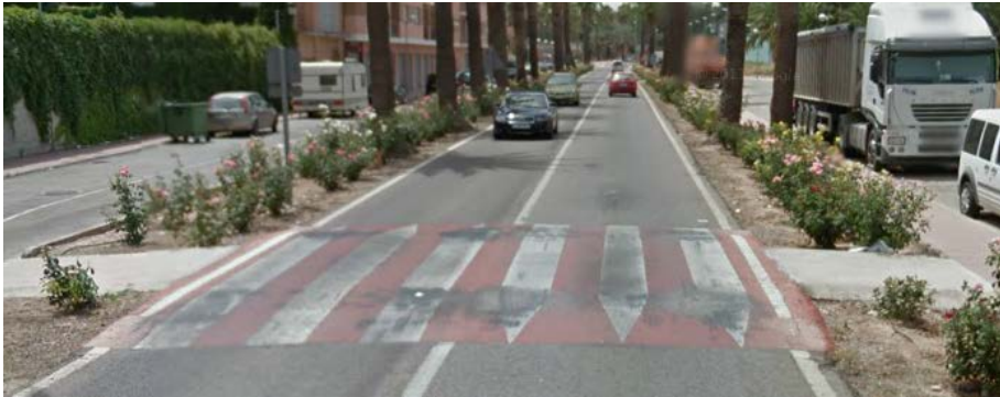
Figura 71. Dispositivo tipo paso elevado en Albalat de la Ribera, Valencia.
