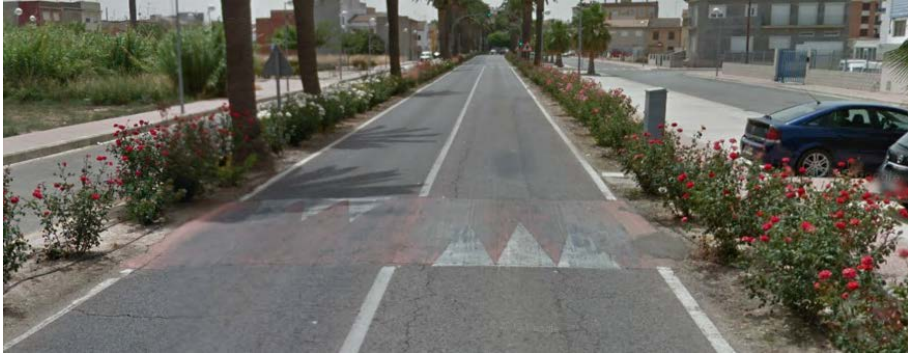
Figura 70. Dispositivo tipo lomo en Albalat de la Ribera, Valencia.
