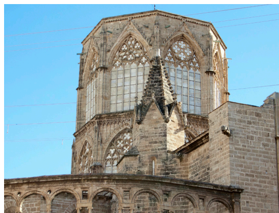
Fig.14: Vista del cimborrio. Catedral de Valencia
