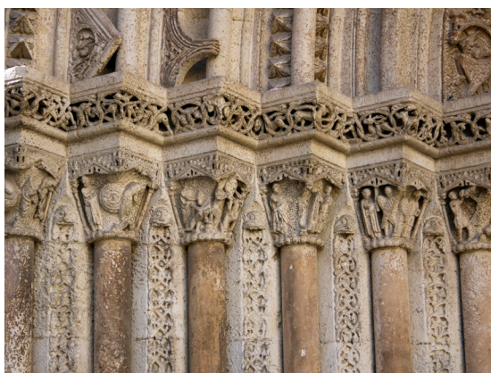
Fig.12: Detalle de los capiteles de la puerta del Palau . Catedral de Valencia
