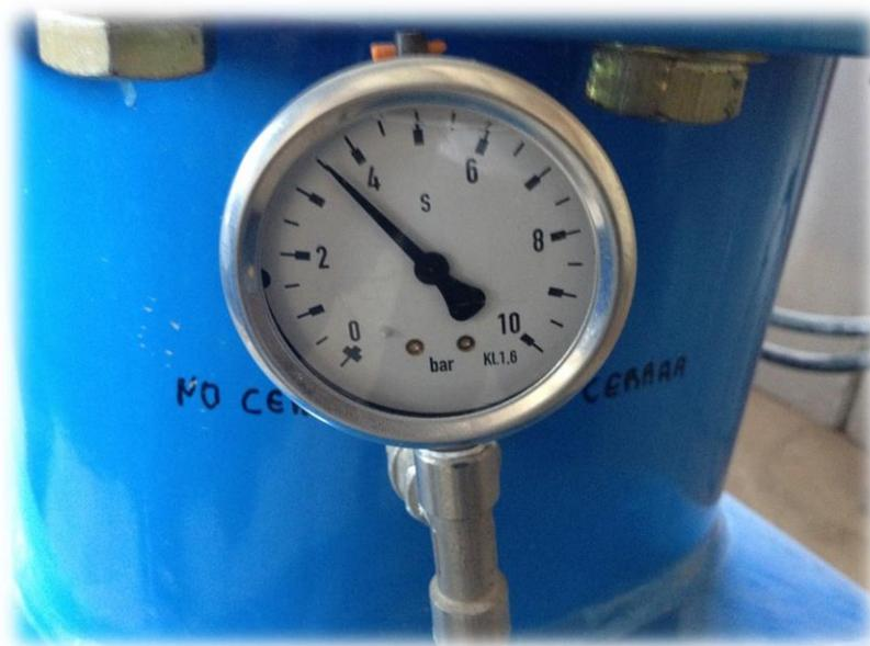
*Fotografía 15: Manómetro que registra la presión de salida del bombeo.*
