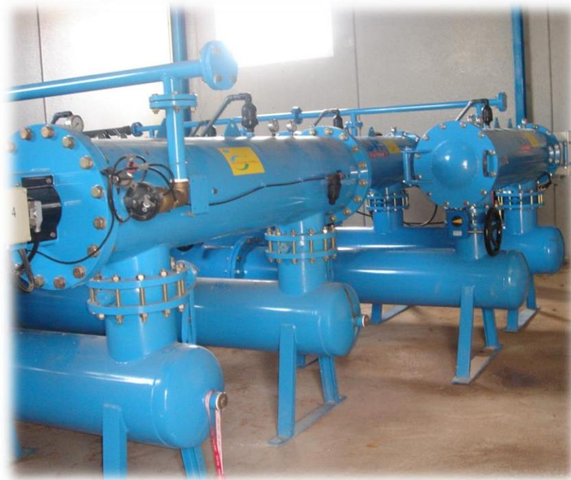
*Fotografía 8: Vista de las unidades de filtro de malla de la estación de filtrado nº1.*
