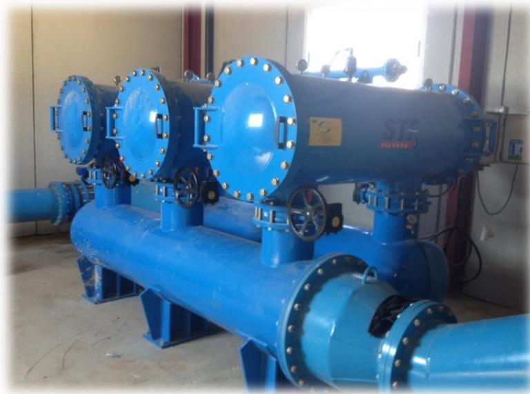
*Fotografía 9: Vista de las unidades de filtro de malla de la estación de filtrado nº2.*
