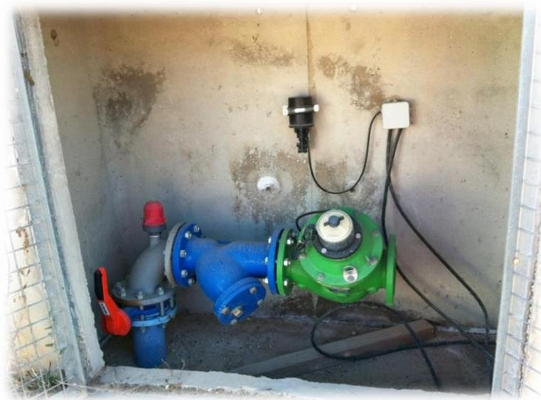
**Fotografía 16:** Vista de uno de los hidrantes con equipo de automatización.
