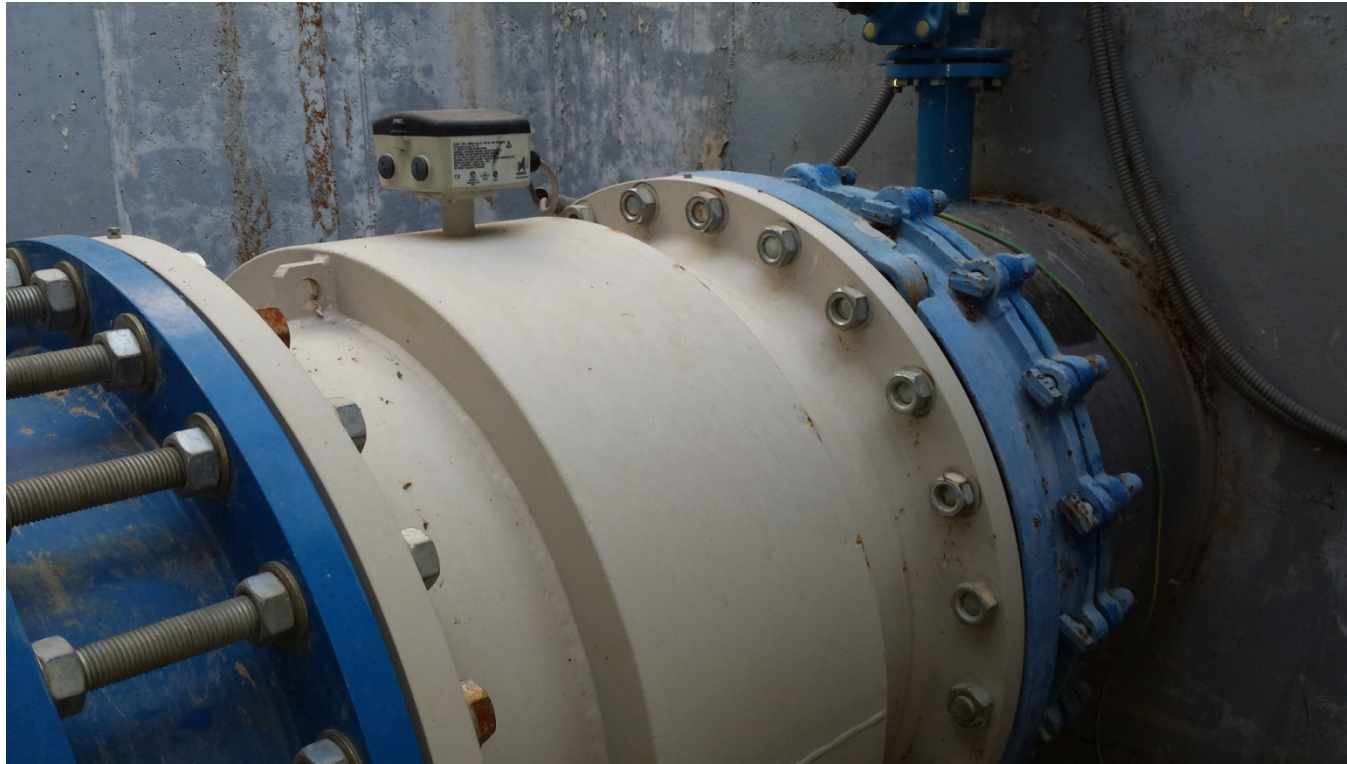
DETALLE CAUDALÍMETRO ELECTROMAGNÉTICO.
