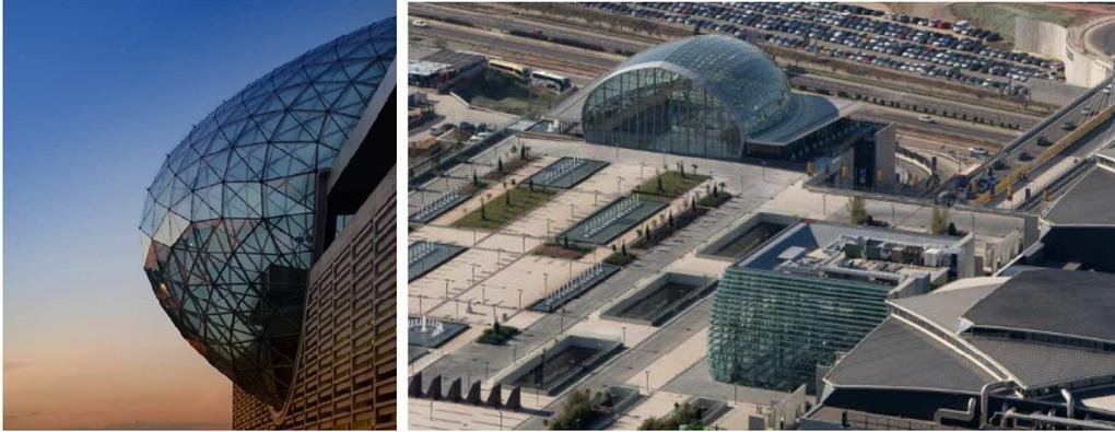
FIGURA 6.2. Centro de eventos de Feria Valencia. *Izquierda:* Detalle de la panelización del elipsoide. *Derecha:* Vista general de la terraza.
