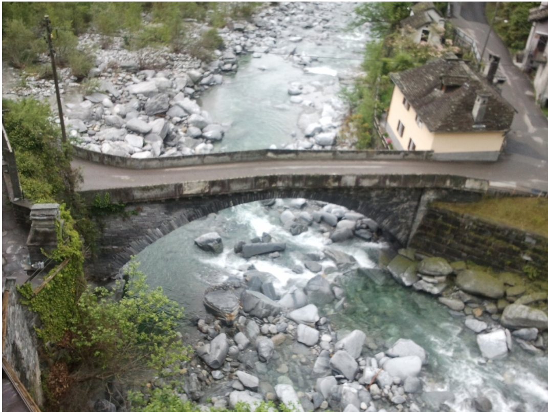
Imagen del puente sobre el río Rovana en Cevio.
