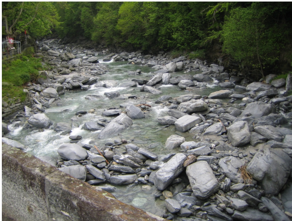
Vista aguas arriba del puente
