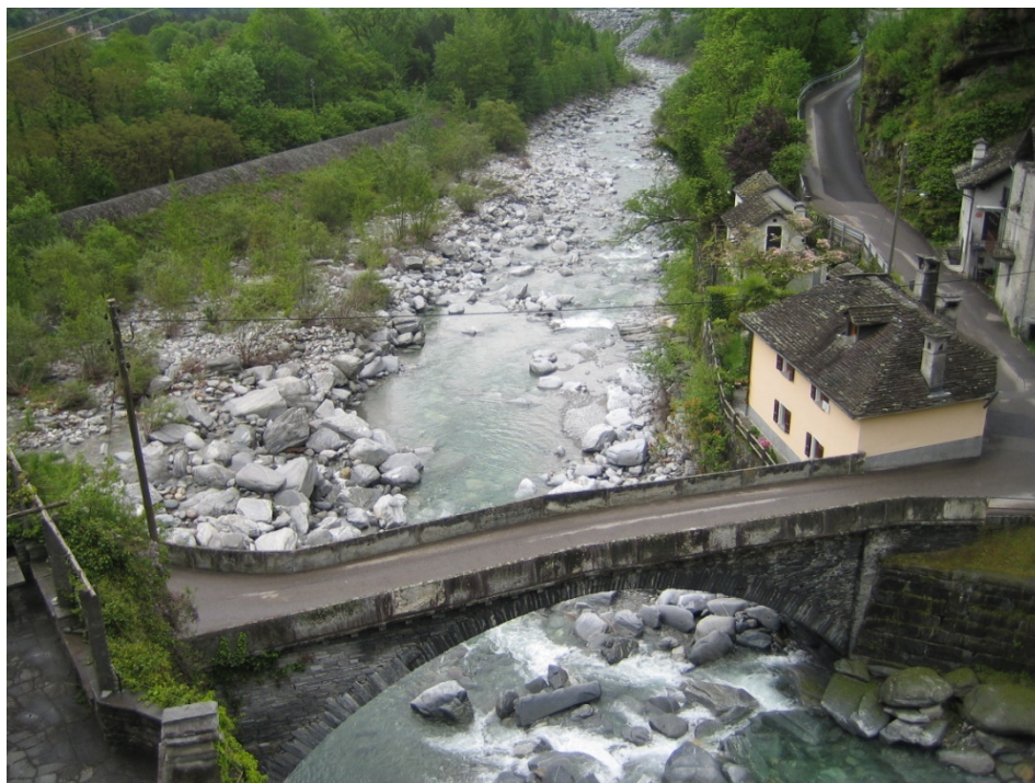
Vista aguas abajo del puente
