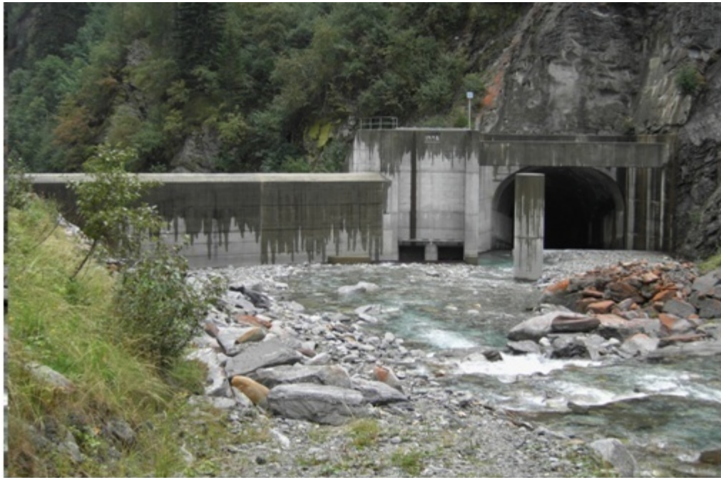
Estación de turbinaje
