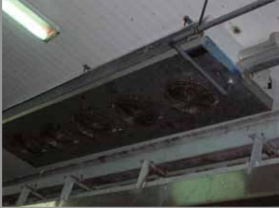
Para salas a +12°C se utiliza R-717 como refrigerante primario, a partir del cual y en la sala de máquinas se produce una línea de glicol frío, siendo una solución acuosa de etilenglicol el fluido refrigerante secundario a recircular por las baterías colocadas en la sala
