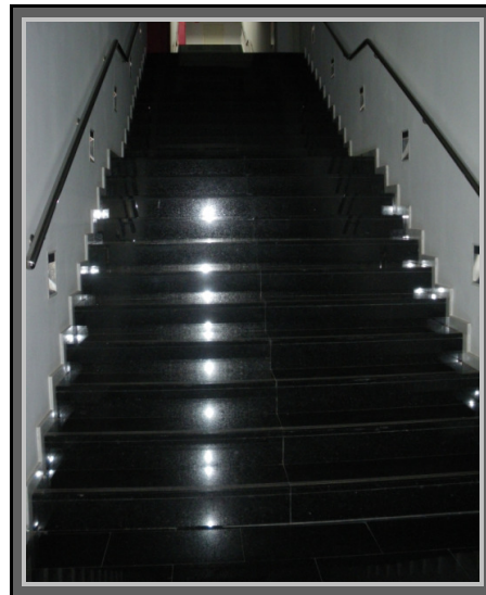
Ilustración 35. Escalera 4, P1 (Edificio 1C).
