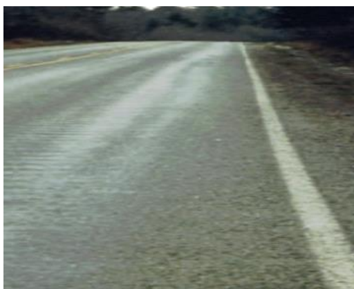
Figura 6: Ondulazione
