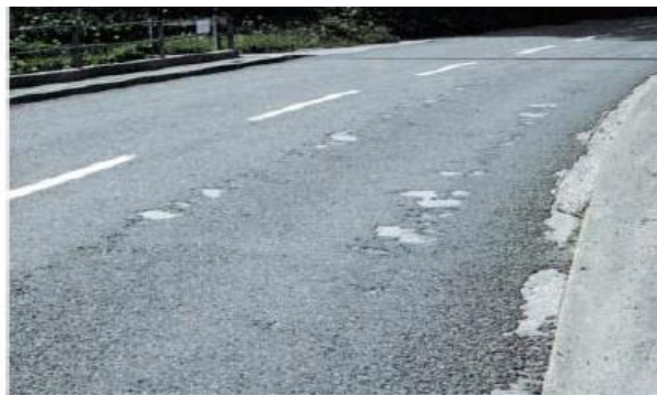
Figura 3: Distacchi dello strato più sterno della pavimentazione
