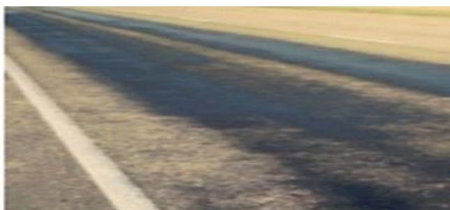
Figura 1: Rifluimento del legante bituminoso
