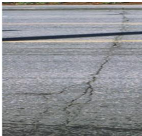
Figura 10: Fessura trasversale
