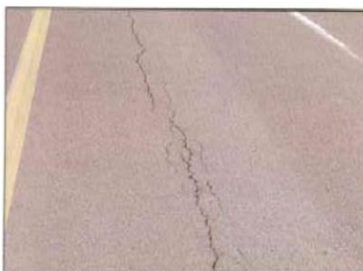
Figura 9: Fessura longitudinale
