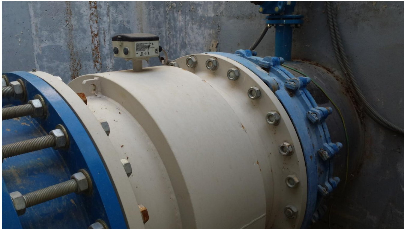
DETALLE CAUDALÍMETRO ELECTROMAGNÉTICO.
