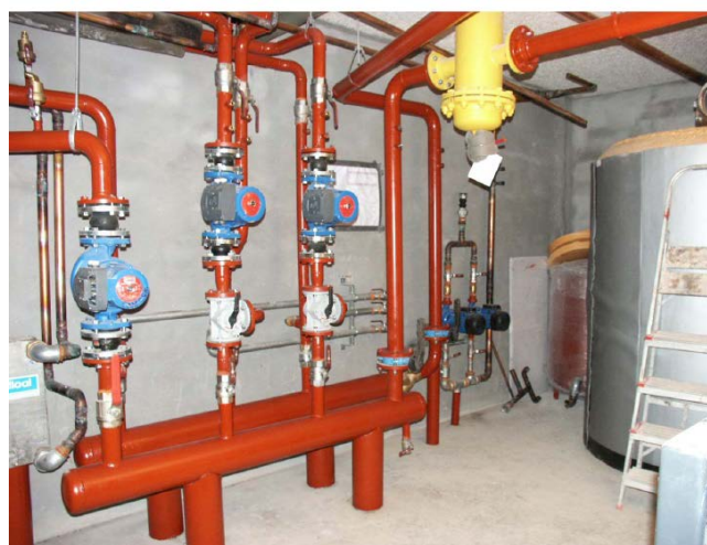
Imagen 20.8: Colectores de BERMEO
