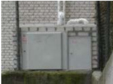
Imagen 21.1: Armario de regulación
