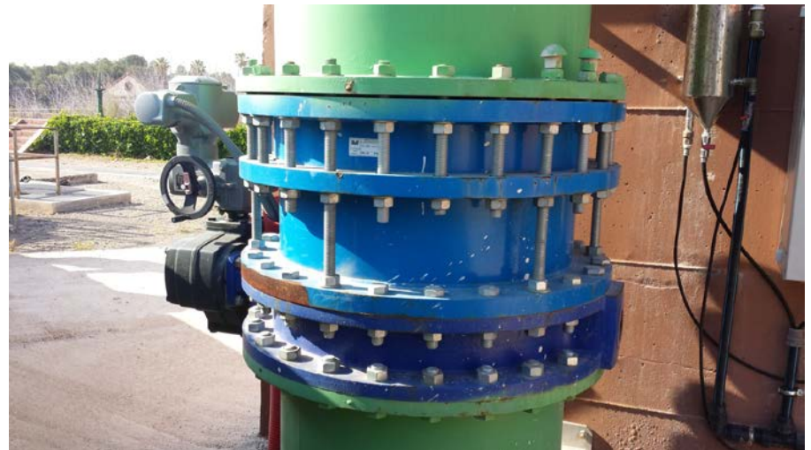
DETALLE VÁLVULA ELECTROMAGNÉTICA DE MARIPOSA
