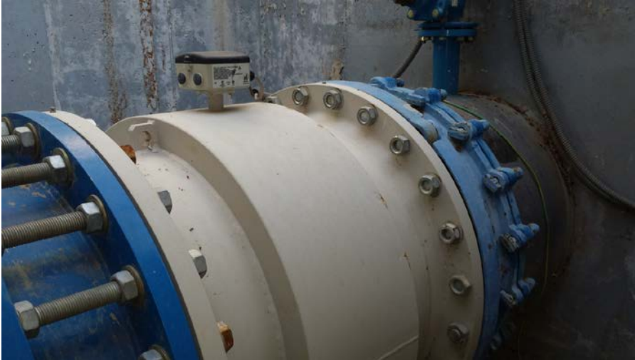
DETALLE CAUDALÍMETRO ELECTROMAGNÉTICO.
