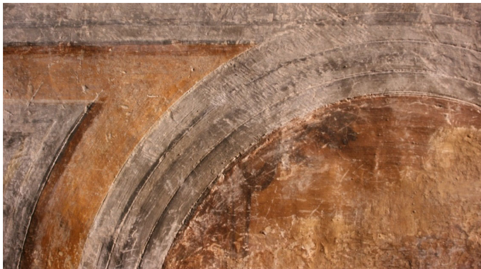
Figura 22 Giner Cordero, E. Particolare dei dipinti della Cappella Camuzio. Segni delle martelline utilizzate nelle operazioni di descialbo. Chiesa di Santa Maria degli Angioli, Lugano. Enero 2008.
