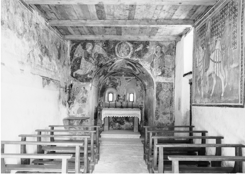
Figura 78 Interno dell'Oratorio di San Martino dopo il restauro. 1929 ca. XV sec. Fotografia b/n, 1929 ca. AUBCBZ, Archivio grafico. Quinto, san Martino a Deggio.
