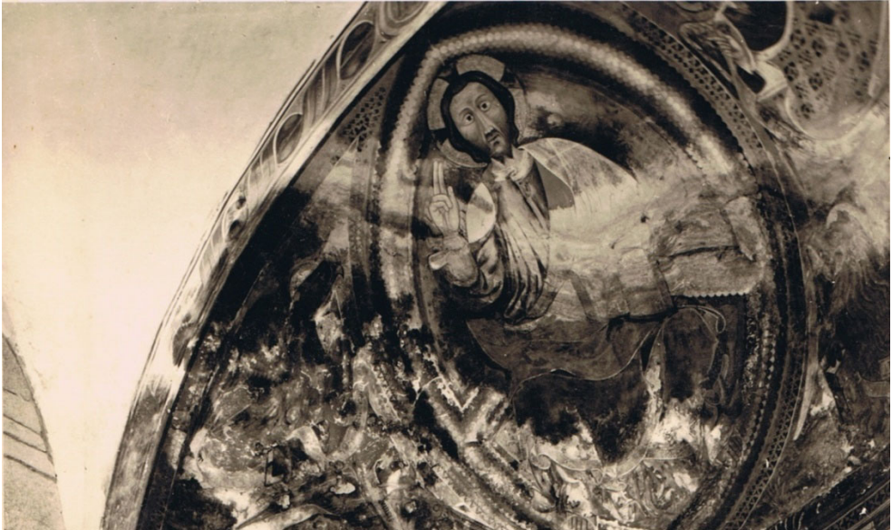
Figura 141 Abside della chiesa di S. Nicolao prima dei restauri, 1944 ca., Giornico. Archivio privato B.Abbiati.
