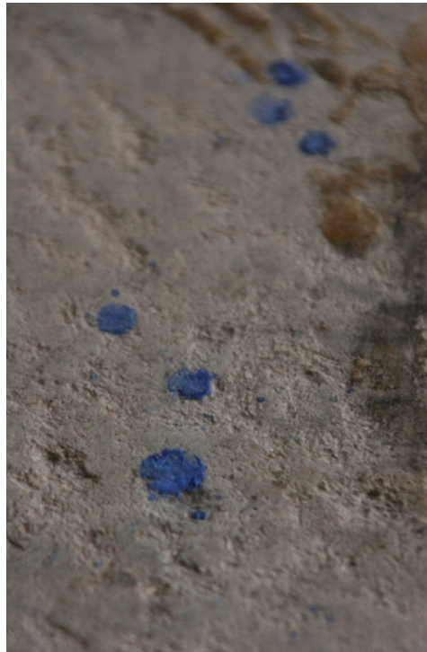
Figura 137 Giner Cordero, E. Particolare del pigmento blu ritrovato sopra l'altare dell'abside maggiore alla chiesa di s. Carlo di Negrentino, dimostrando i rifacimenti eseguiti durante i lavori di restauro degli anni Quaranta. 2008.
