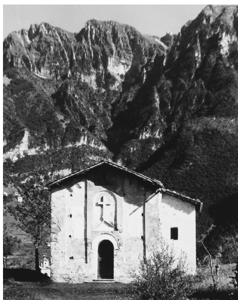
Figura 148 Veduta esterna. Facciata prima del restauro. In fondo il Monte Generoso. Rovio, S. Vigilio, Restauro 1949 ca. Archivio Federale dei Monumenti Storici. Collezione grafica, Biblioteca nazionale svizzera.
