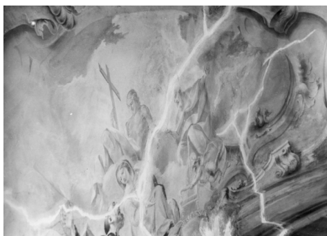
Figura 174 Stuccatura delle fessure. Chiesa di S. Antonio, Lugano. Fotografia b/n. AUBCBZ Archivio grafico, Lugano, S. Antonio Abate.
