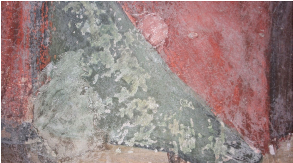
Figura 25 Giner Cordero, E. Particolare dei dipinti della Cappella Camuzio. Dettaglio del ritocco a basso tono delle lacune. Chiesa di Santa Maria degli Angioli, Lugano. Gennaio 2008.
