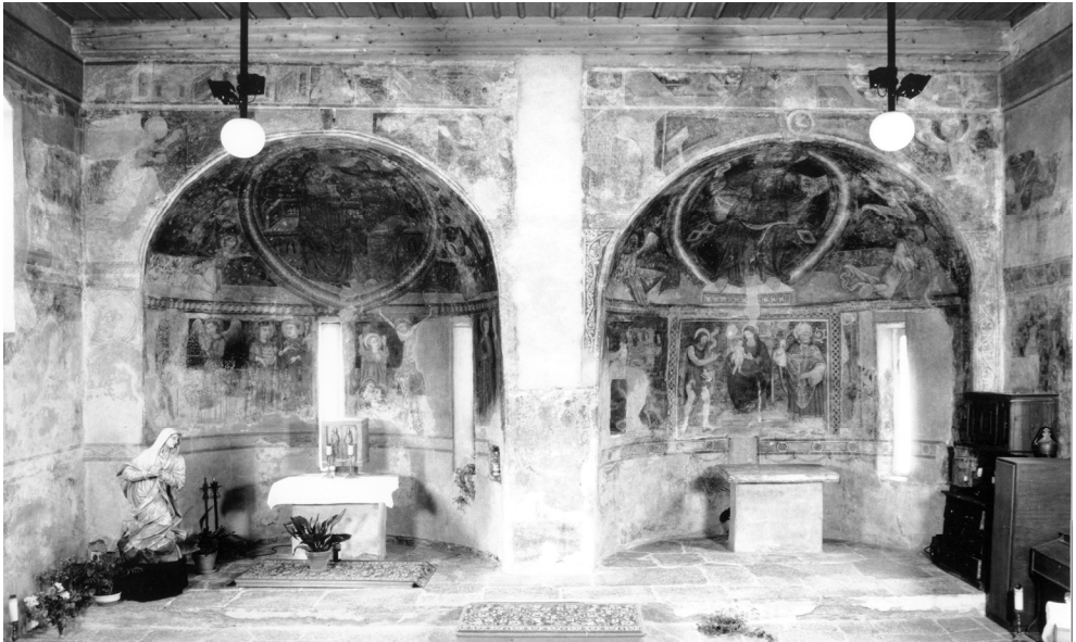
Figura 91 Fotografia dell'Interno della chiesa dopo il restauro, 1950 ca. AUBCBZ. Chironico. S. Ambrogio.
