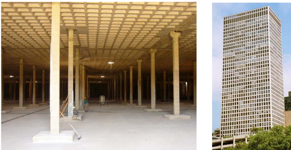
Figura 1.11. Forjado reticular (1.11.a). Apartamentos DeWitt-Chestnut en Chicago (USA). Estructura tipo tubo. Ing. F. Kahn (1.11.b).
