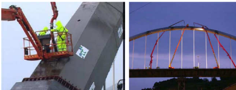
Figura 2.1. Hormigonado del arco del viaducto sobre los ríos Anleo y Navia. Izquierda comienzo hormigonado, derecha culminación del arco (Navarro, 2009)
