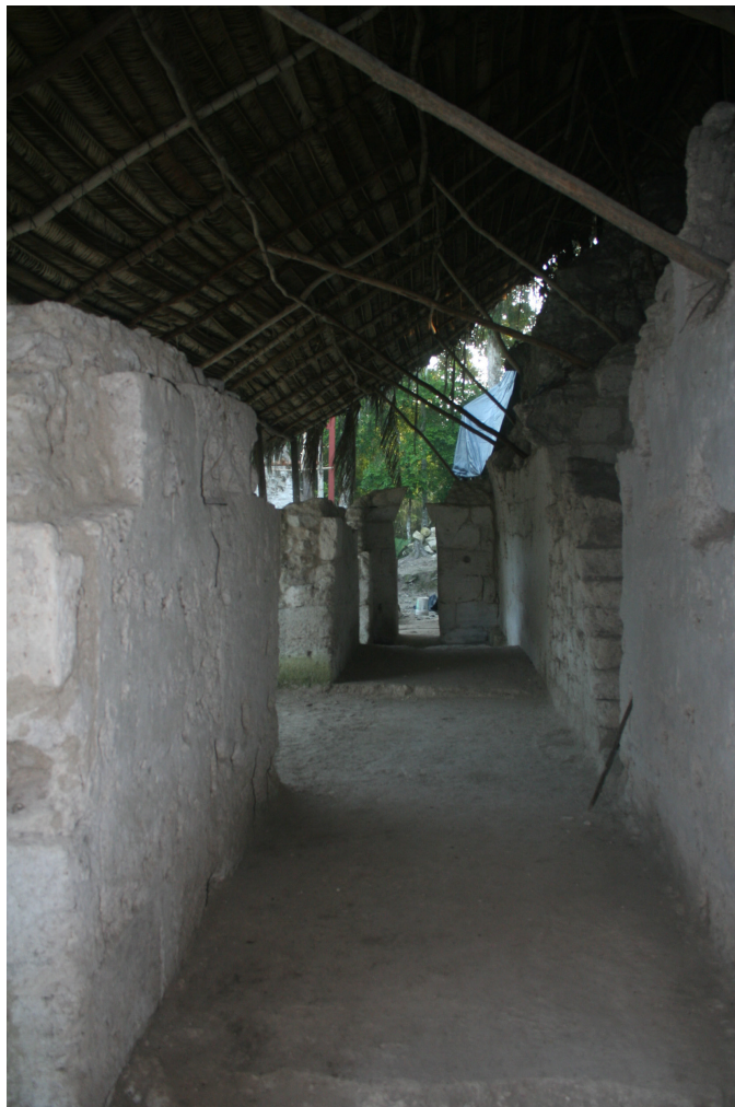
Figura 118. Puerta al Este del cuarto 7 del ala Sur del edificio 6J2 después de su intervención. Cortesía del Proyecto La Blanca.
