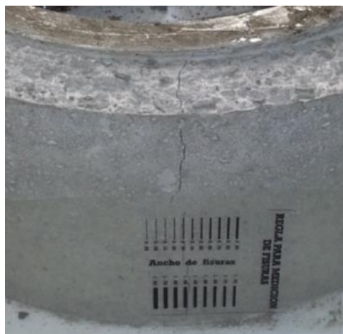
Ilustración 36: Regla de ancho de fisura, fisura en espécimen de hormigón.
