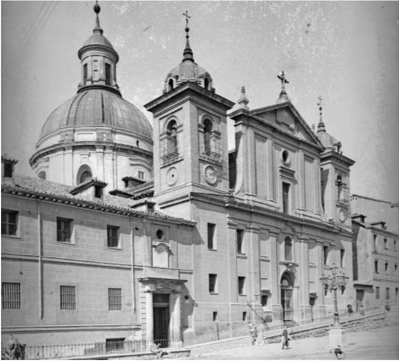
Escuelas Pías de San Fernando. Foto: A. Passaporte 1927-1936 (fuente: Loty. Fototeca del Patrimonio Histórico)
