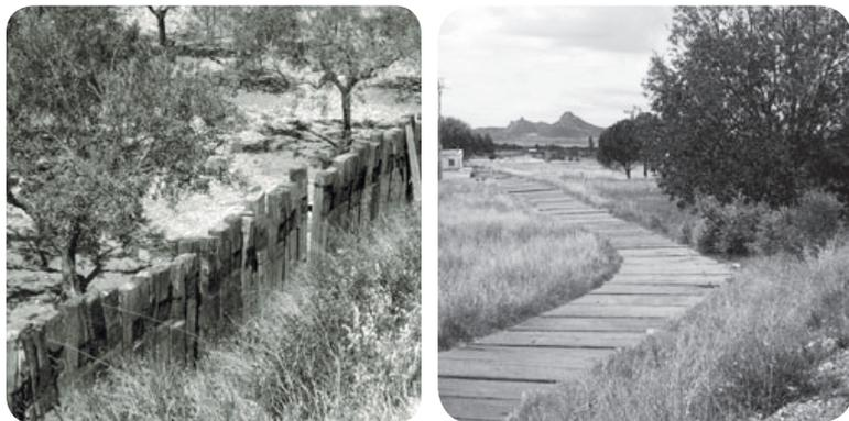
Imagen 5.2. Vallado y pavimento con traviesas de madera de antiguas vías de ferrocarril. Antiguo trazado Madrid-Alicante. Fuente: María Mestre Martí.
