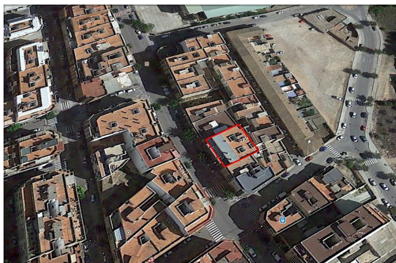
Figura 25 – Ubicación del edificio en Calle Pla de l'Arc, nº 40 de Lliria (Valencia), 2014.
