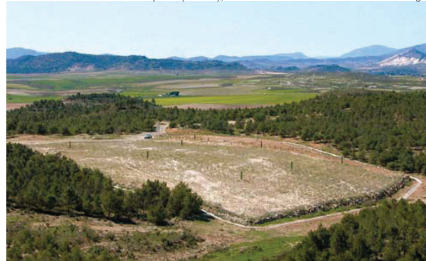
Vista del vertedero de Calasparra (Murcia), con las chimeneas de extracción de biogás.
