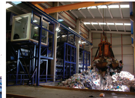
Foso de recepción
