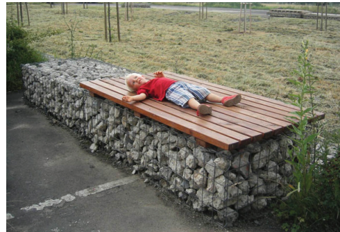
Bancos-gaviones rellenos de escombros.
