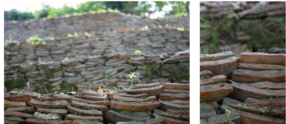
Detalle del sistema de aterrazamiento mediante desechos de ánforas.
