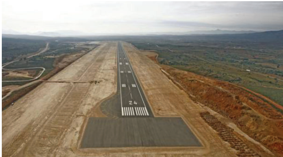
Aeropuerto de Castellón en proceso de ejecución.
