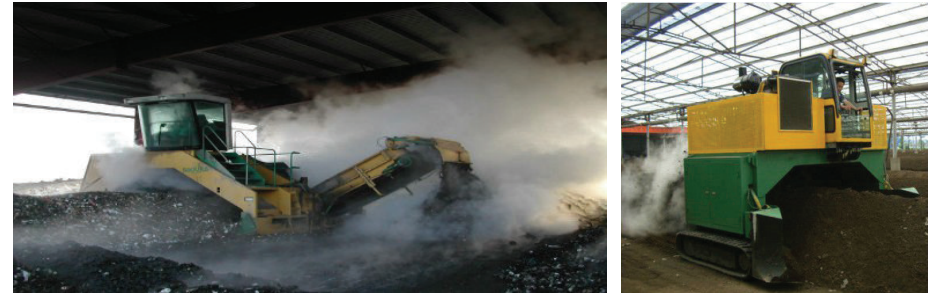
Operaciones de volteo.
