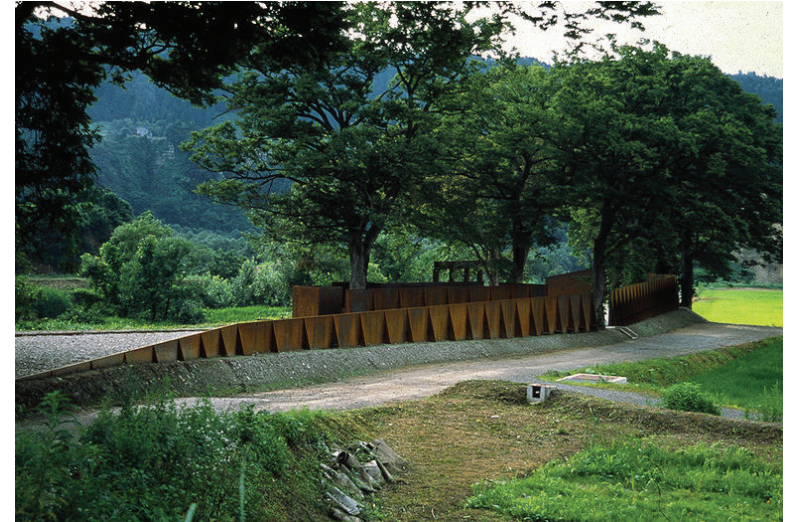
Muro perimetral de acero corten.
