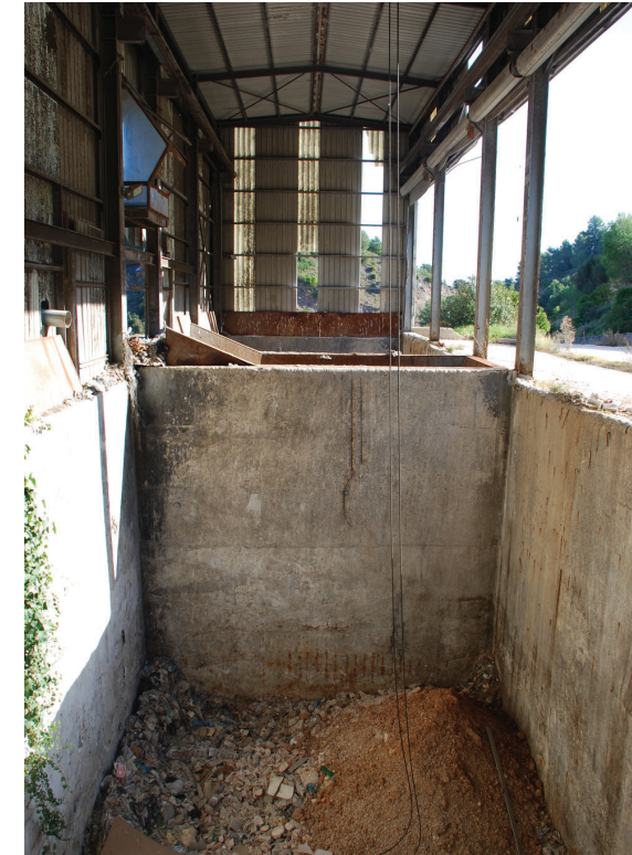
01 Detalle de la nave y foso de depósito.
