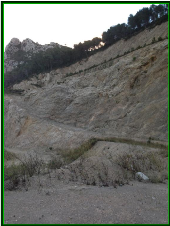
Fotografía nº 11. Vistas de la parte sudeste de la cantera en la zona de actuación 1.
