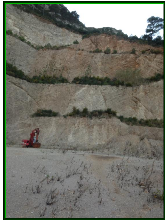
Fotografía nº 12. Vistas de la parte sudoeste de la zona de actuación 1 de la cantera.
