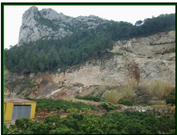
Fotografía nº 3. Vistas de la parte sureste de la zona de actuación 1.
