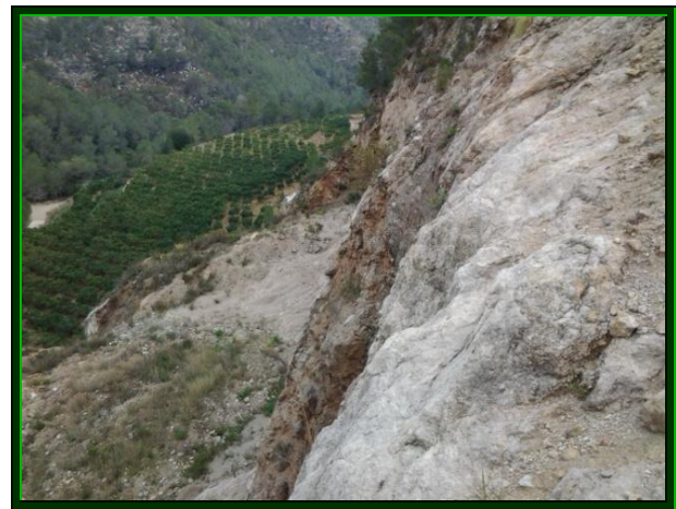
Fotografía nº 9. Vista de la zona sudeste de la zona de actuación 1 visualizada desde el punto 5.
