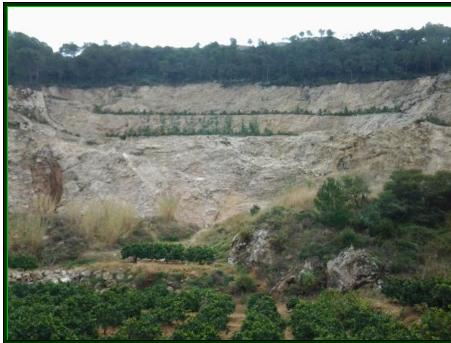
Fotografía nº 2. Vistas de la zona central de la zona de actuación 1 de la cantera.
