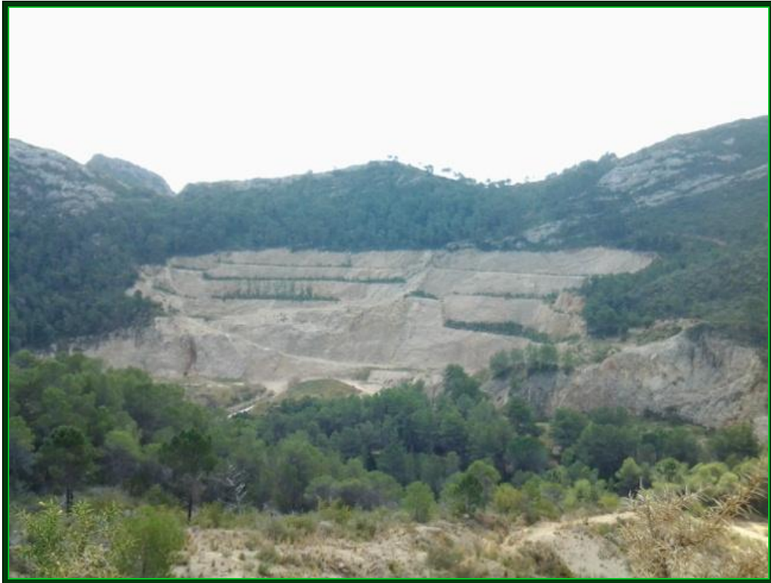
Fotografía nº 1. Vistas generales de la zona de actuación 1.
