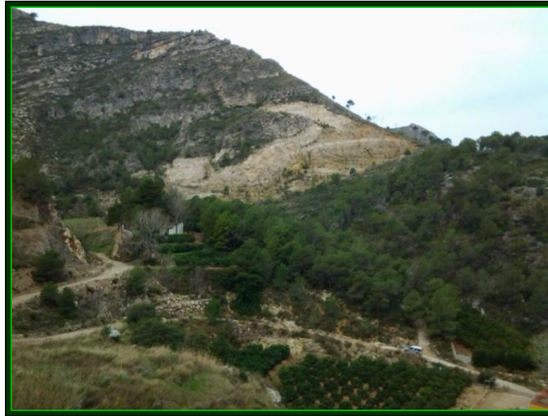
Fotografía nº 18. Vistas de la zona de actuación 2 desde la zona de actuación 1.
