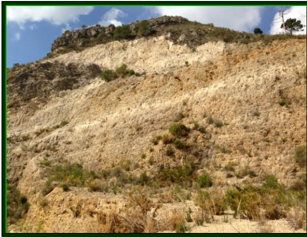
Fotografía nº 19. Vistas de la zona de actuación 2 donde se observa el talud más pronunciado.
