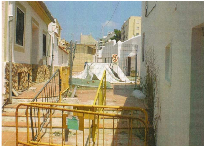
Fig. 33. Corte de la calle peatonal y protección de la chimenea de ventilación. 2012. Expte. 9/2012 Archivo del Ayuntamiento de Paterna.
