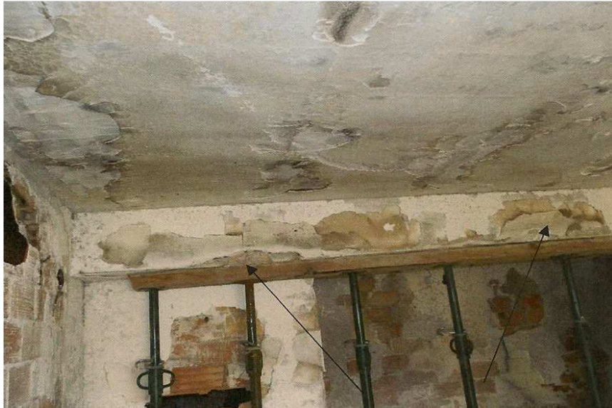
Fig. 13. Detalle del apuntalamiento de la viga. 2012. Expte. de ruina nº 11/2012 del archivo del Ayuntamiento de Paterna.
