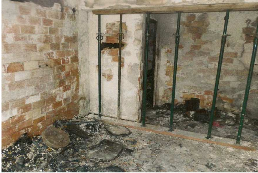
Fig. 12. Detalle del apuntalamiento de la viga. 2012. Expte. de ruina nº 11/2012 del archivo del Ayuntamiento de Paterna.
