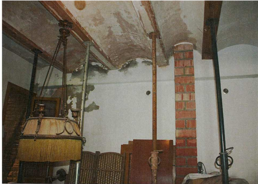
Fig. 32. Apuntalamiento de viguetas de madera. 2012. Expte. 9/2012 Archivo Ayuntamiento de Paterna.
