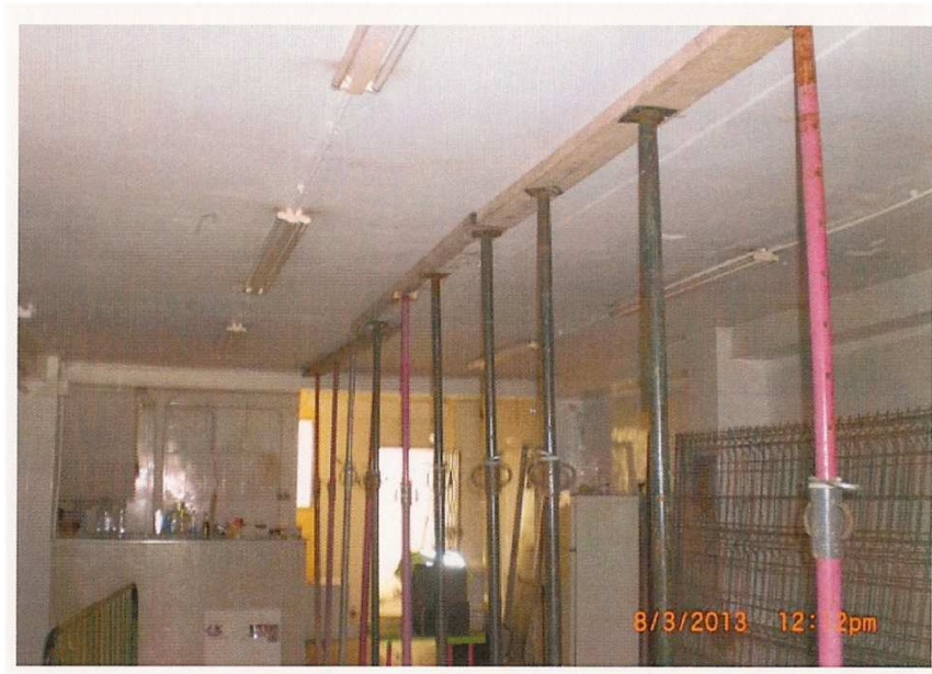
Fig. 22. Apuntalamiento forjado primero. 2013. Expte. 11/2013 Archivo del Ayuntamiento de Paterna.
