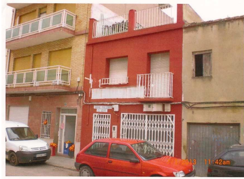
Fig. 16. Fachada y acopio de enseres varios en la cubierta. 2013. Expte. 11/2013 Archivo del Ayuntamiento de Paterna.
