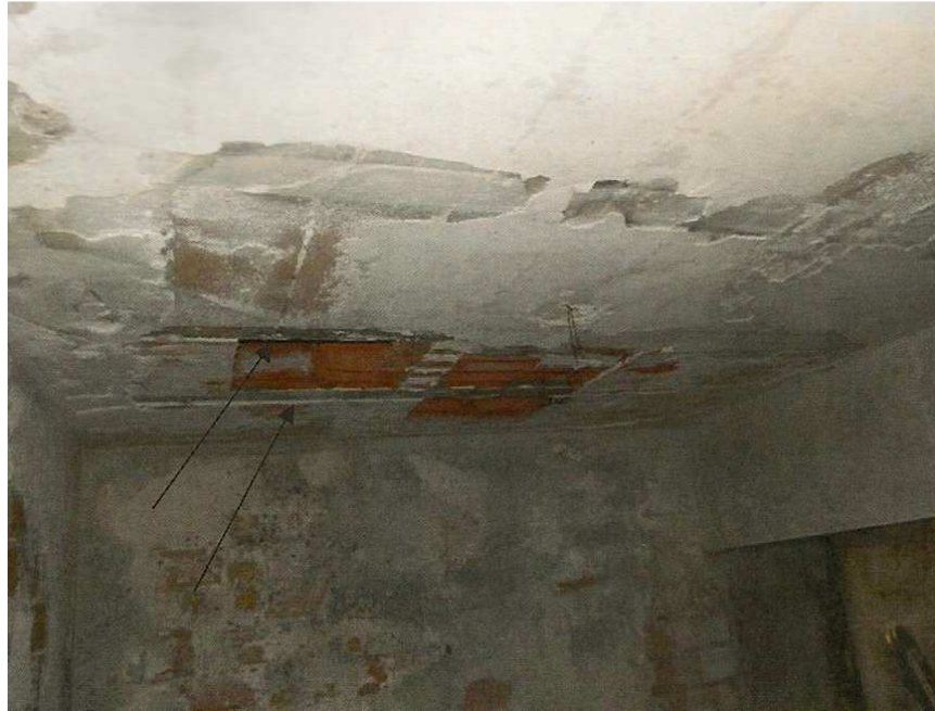
Fig. 14. Detalle del techo sin el revestimiento y sin daños. 2012. Expte. de ruina nº 11/2012 del archivo del Ayuntamiento de Paterna.
