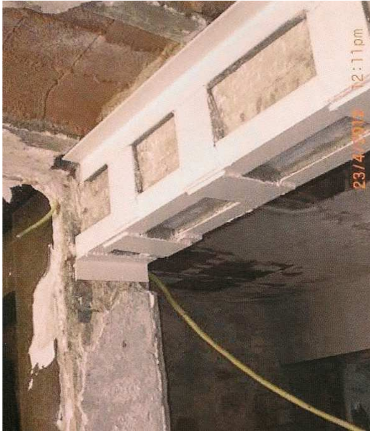
Fig. 15. Detalle de la reparación efectuada en la viga. 2012. Expte. de ruina nº 11/2012 del archivo del Ayuntamiento de Paterna.
