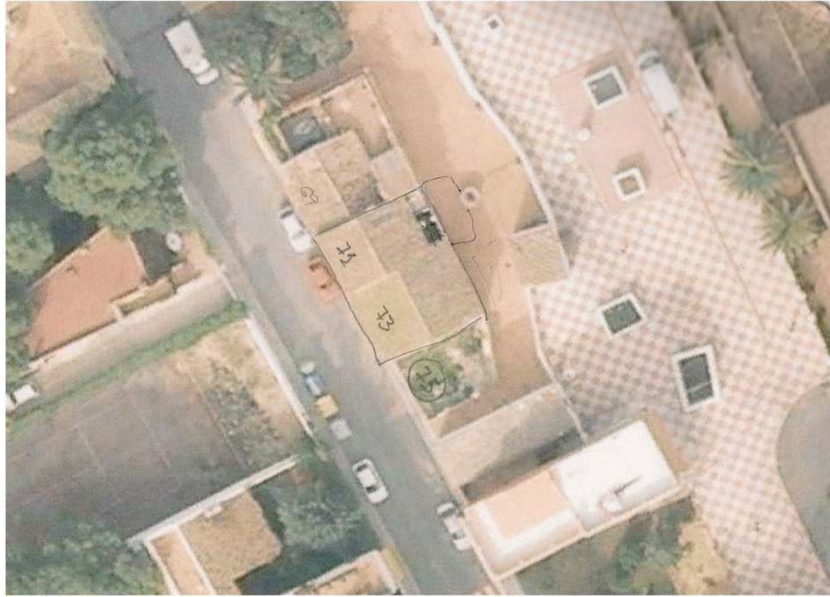
Fig. 28. Situación de las viviendas. Son las nº 71 y 73. Derrumbe por su parte posterior a calle peatonal. 2012. Expte. 19/2012 Archivo del Ayuntamiento de Paterna.
