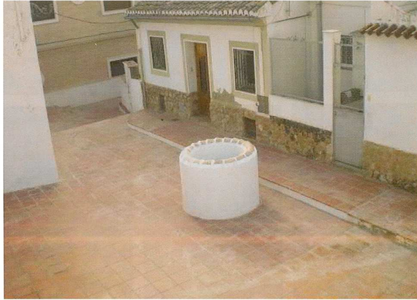
Fig. 43. Reparación terminada. 2012. Expte. 9/2012 Archivo del ayuntamiento de Paterna.
