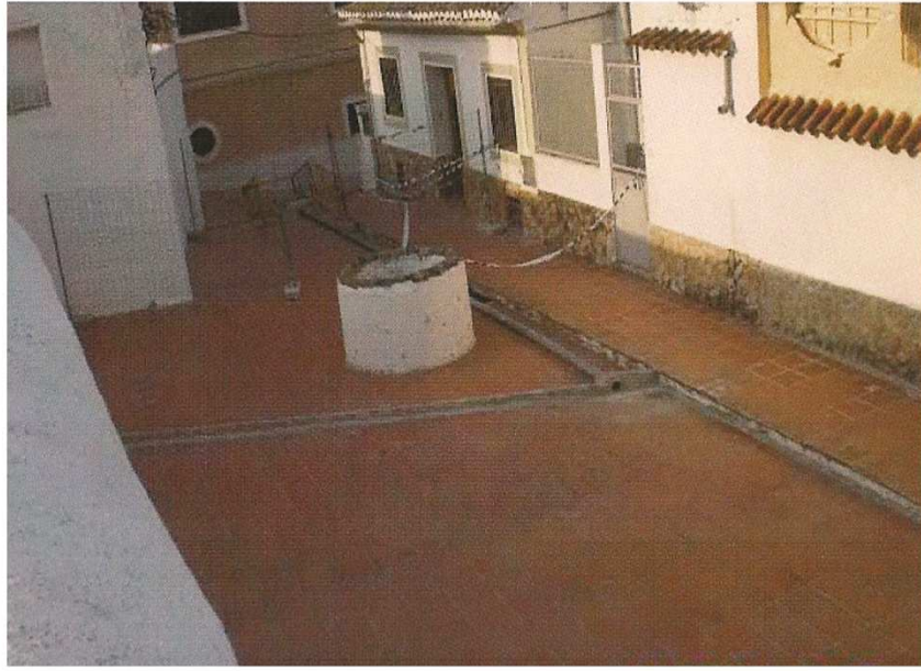
Fig. 37. Fachada posterior de las viviendas afectadas. Se observan las ventanas que ventilan las cuevas y la chimenea de ventilación. 2012. Expte. 9/2012 Archivo del Ayuntamiento de Paterna.
