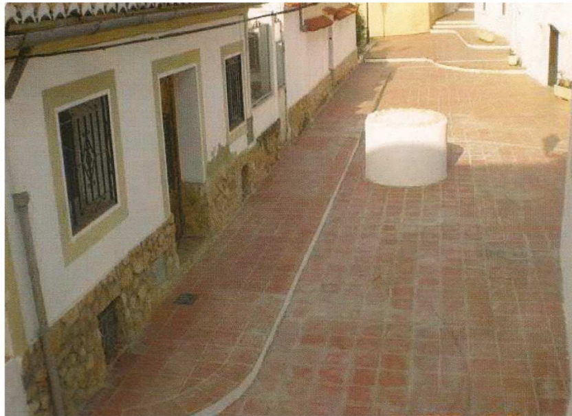
Fig. 42. Reparación efectuada. 2012. Expte. 9/2012 Archivo del ayuntamiento de Paterna.
