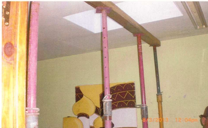
Fig. 23. Apuntalamiento forjado segundo. 2013. Expte. 11/2013 Archivo del Ayuntamiento de Paterna.
