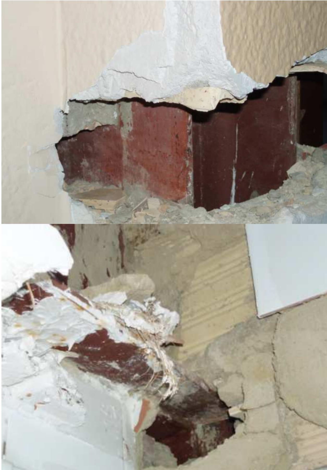
Figura 10. Catas en vigas y pilares
