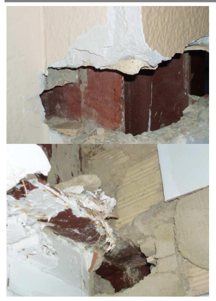
Figura 10. Catas en vigas y pilares
