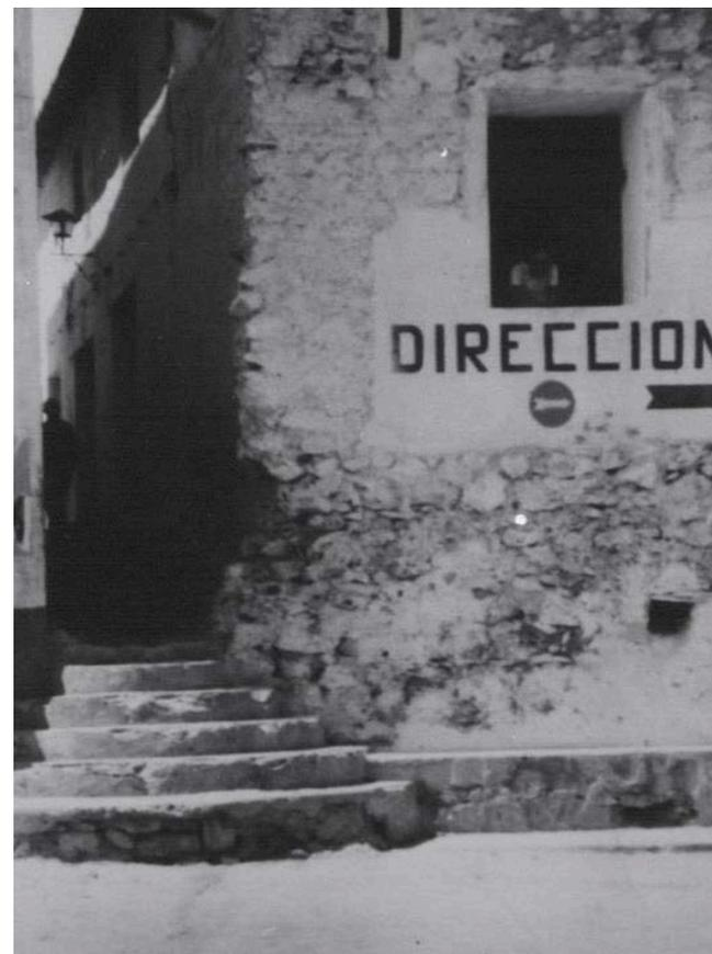
Ilustración 166 Antiguo Portal del Mar. Se observa la técnica constructiva típica de las casas: construcción en piedra (de las cercanías), y revestido mediante una capa de lechada de cal, normalmente blanca, tal y como se aprecia en la imagen
