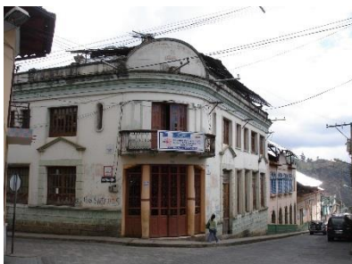
-Foto No.1 Antiguo Hospital de Jesús de Guaranda, antes de su restauración.
