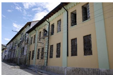
-Foto No.3 Antiguo Hospital de Jesús de Guaranda durante su restauración.
