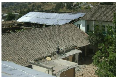
-Foto No.2 Antiguo Hospital de Jesús de Guaranda, durante su restauración.
