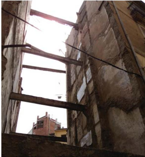
Fig. 69. Medianeras en mal estado. Calle Baja.
