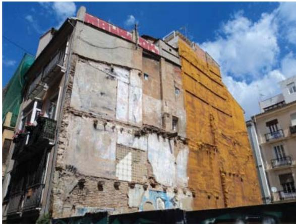
**Fig. 66.** Medianeras sin y con tratamiento de protección realizado con espuma aislante proyectada.
