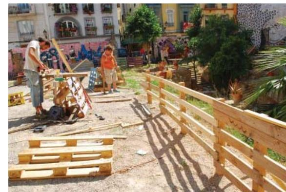
**Fig. 152.** Obras de mantenimiento en el solar Corona: reutilizando palés para construir vallas.
