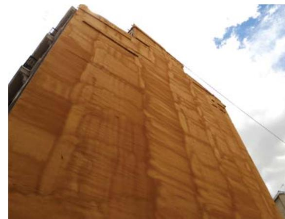
**Fig. 59.** Medianera del solar en la calle Guillem de Castro con acabado en espuma aislante para proteger la pared de la humedad.
