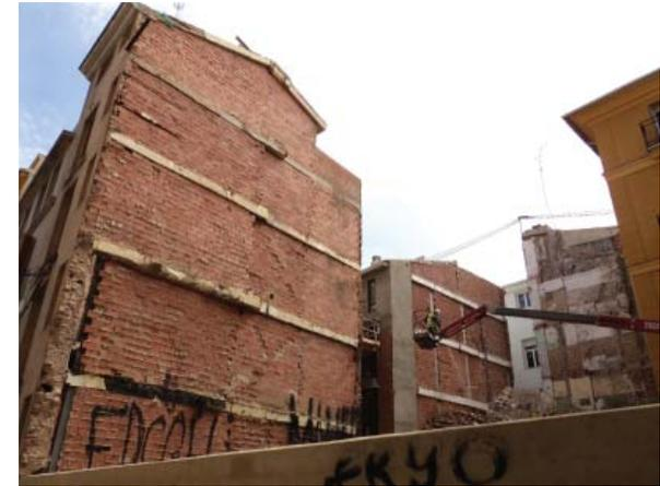
**Fig. 65.** Medianeras sin revestimiento de acabado ni protección. Solares de las calles Pineda (a la izquierda) y Fillol (a la derecha).
