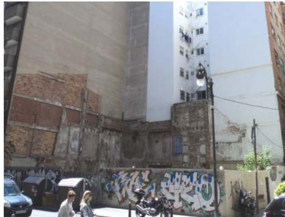
**Fig. 67** Medianeras del solar de la calle Garrigues. Se observan diferentes acabados: descarnado, enfoscado y pintado.
