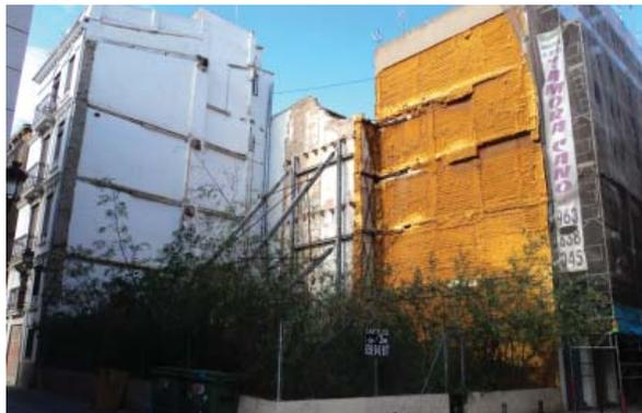
Fig. 70. Apeos en la medianera del solar de la calle Guillem Sorolla.
