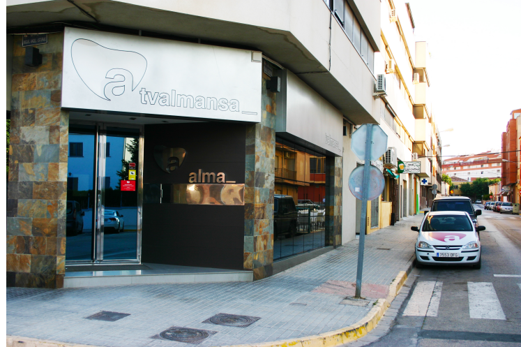
Figura 12: Exterior instalaciones TVAlmansa Calle San Crispín
