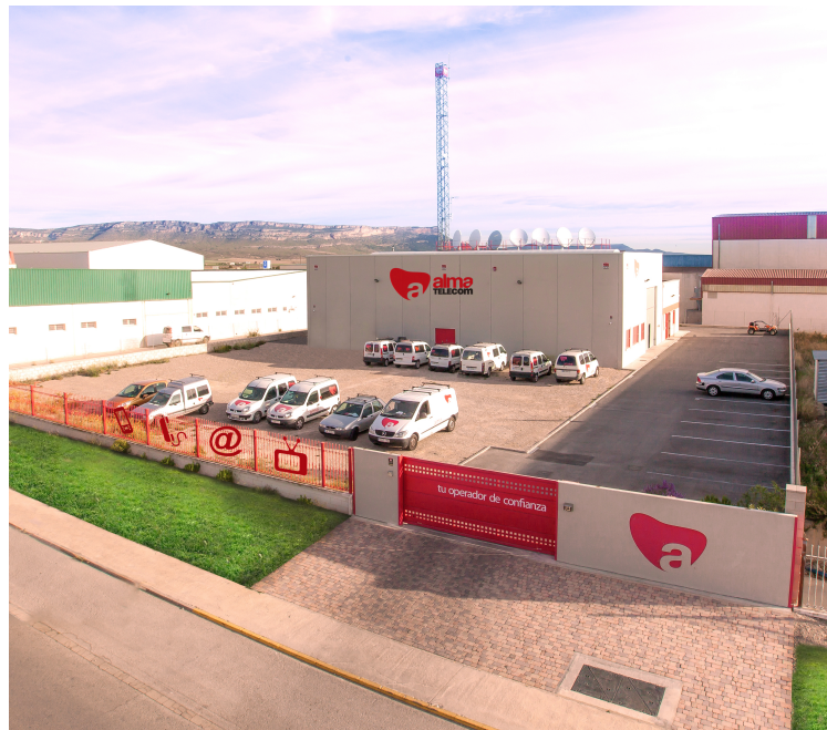
Figura 14: Instalaciones TVAlmansa en el Polígono Industrial “El Mugrón”
