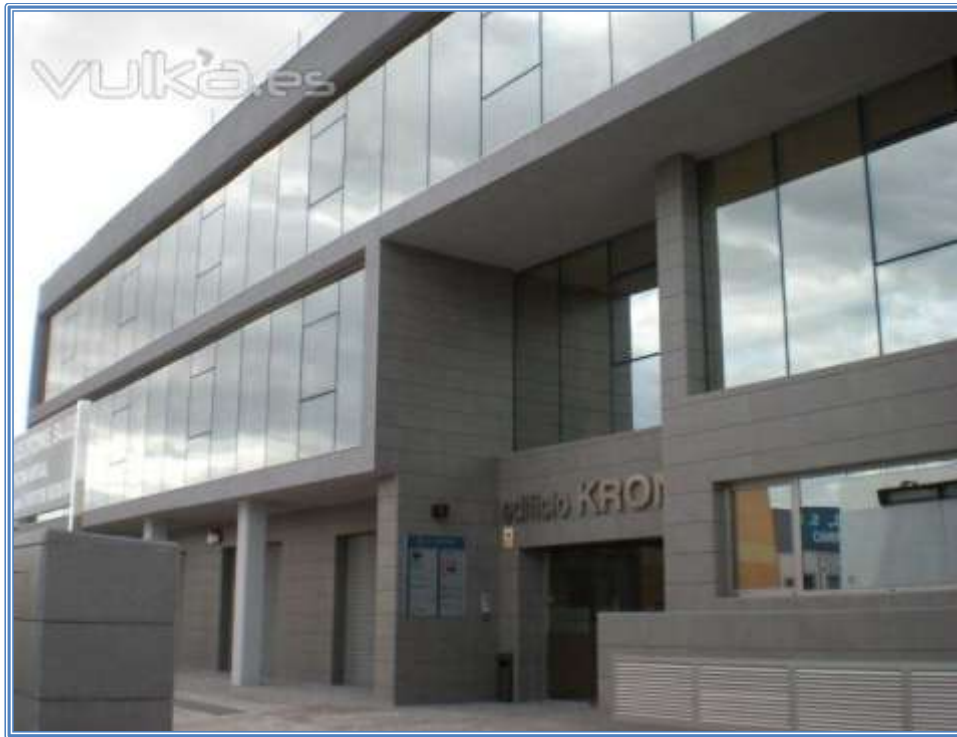
Imagen 3: Edificio Kronos, situado en Polígono de La Pascualeta.
