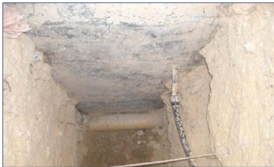
Figura 8 Pintura de impermeabilización
