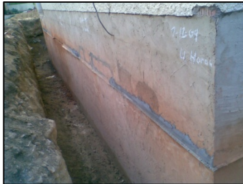
Figura 34 Lateral muro completo
