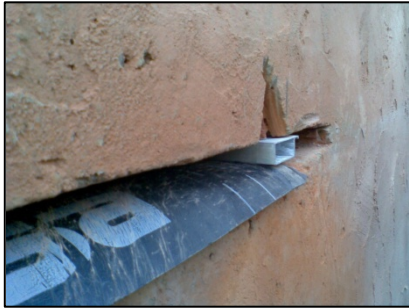
Figura 28 corte exterior + lámina
