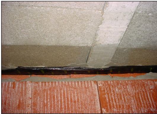
Figura 6 Encuentro muro forjado en espacio no habitado.
