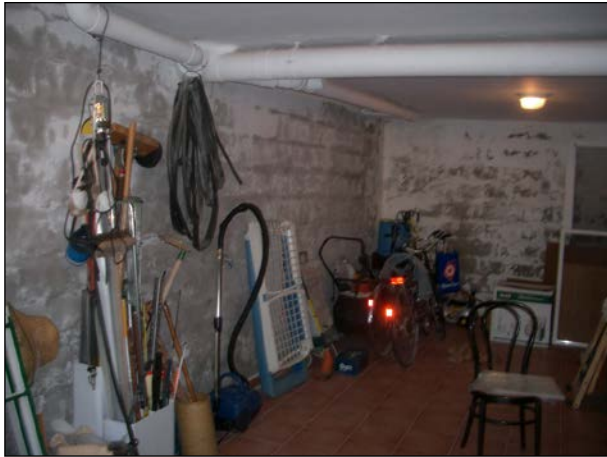
Figura 41 Muro analizado antes de la intervención de 2009
