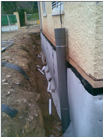
Figura 18 Impermeabilización
